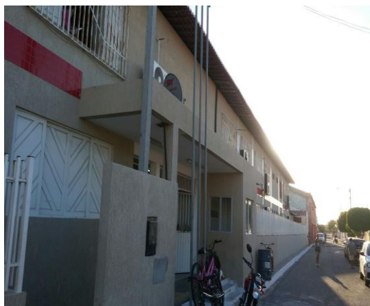
Figura 01: Fachada da Escola
