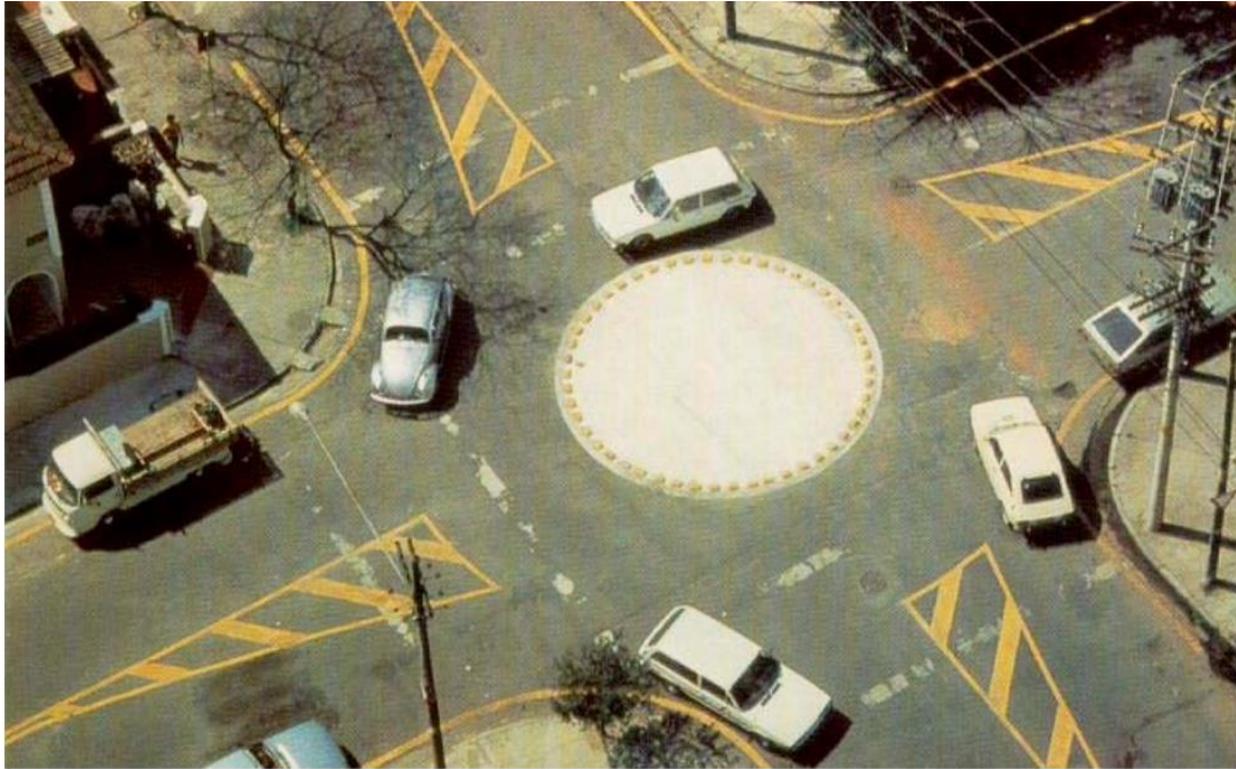
FIGURA 16: ROTATÓRIA EXECUTADA COM “TARTARUGAS” E PINTURA.
