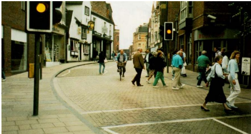
FIGURA 12: PLATAFORMA UTILIZADA EM TRAVESSIA DE PEDESTRES SEMAFORIZADA.
