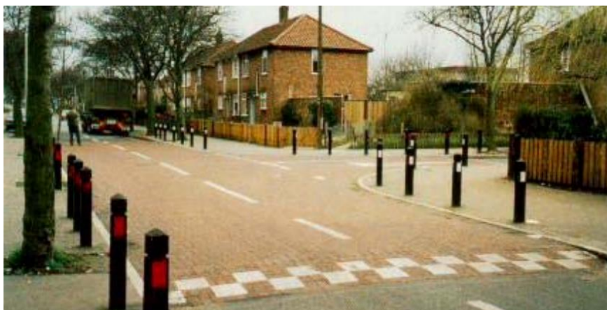
FIGURA 13: PLATÔ - INTERSEÇÃO ELEVADA, DESTACANDO A RAMPA DE ACESSO E OS BALIZADORES QUE DELIMITAM A CALÇADA.
