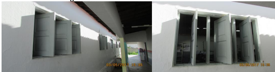
Figura 22 - Janelas instaladas no corredor de acesso.
