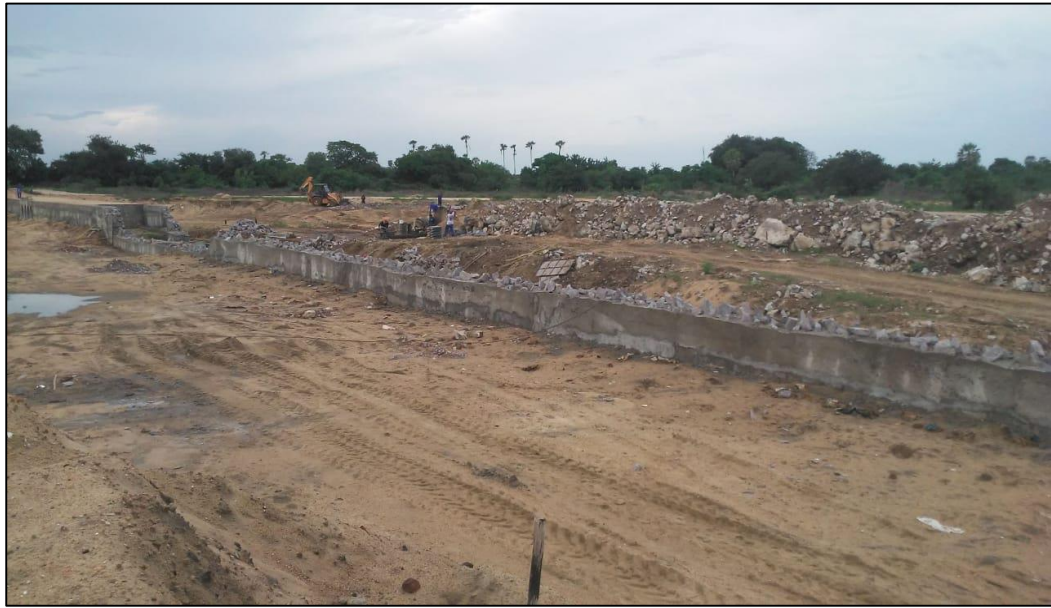
Figura 4: Passagem molhada em execução.
