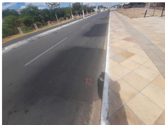
Figura 35 – Defeitos de superfície: Remendos em sequência
