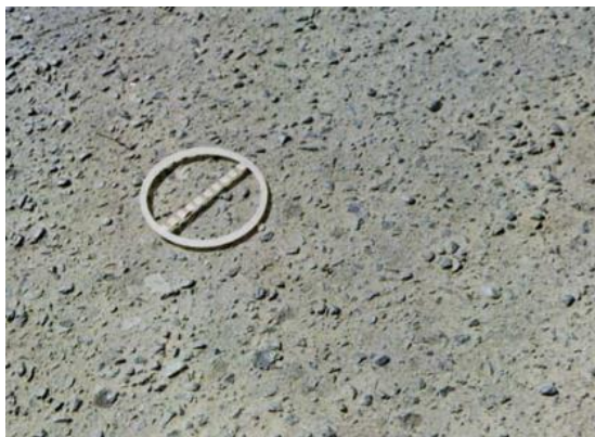
Figura 13 – Desgaste
