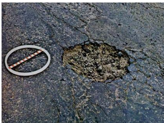
Figura 14 – Panela ou buraco
