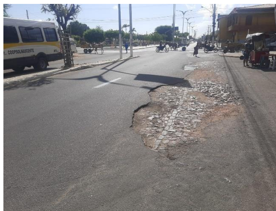
Figura 33 – Defeito de superfície: buraco situado em uma parada de ônibus
