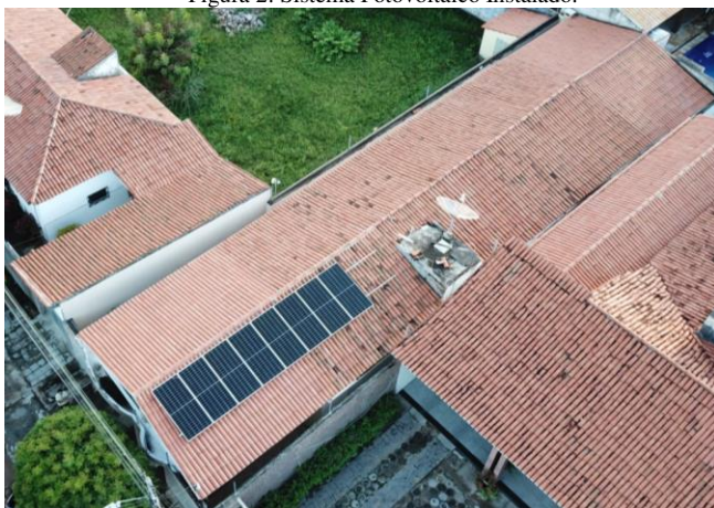
Figura 2: Sistema Fotovoltaico Instalado.
