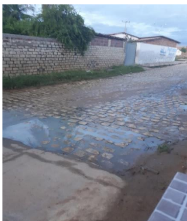
Figura 3. Esgotamento à céu aberto. (Autoria própria)
