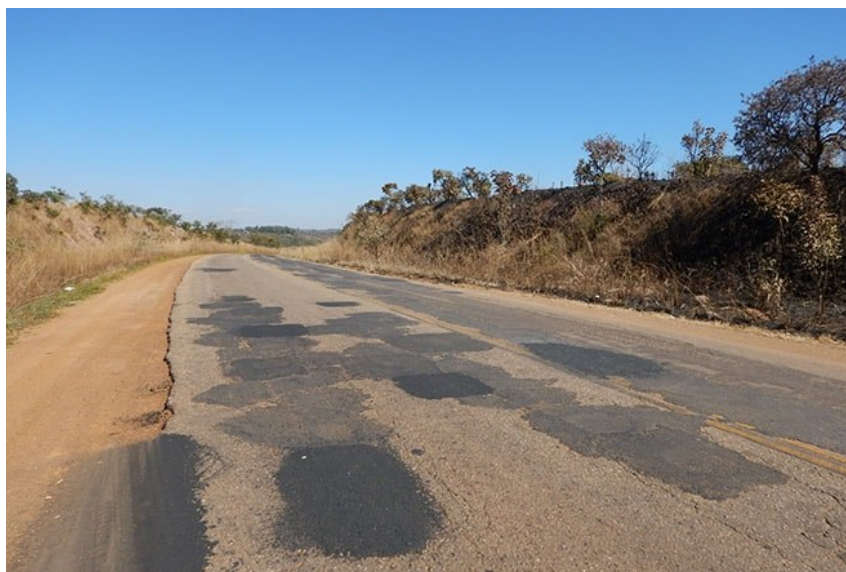
Figura 19: Remendo superficial
