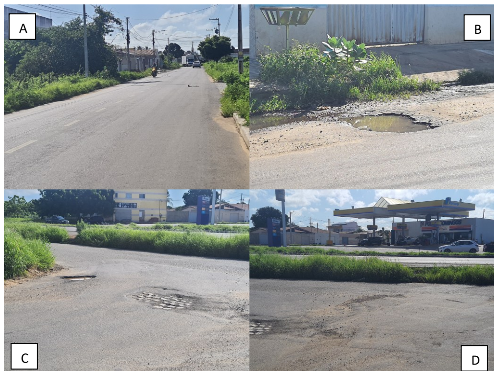
Figura 39: A) Desgaste; B) e C) Pâneas; D) Remendo
