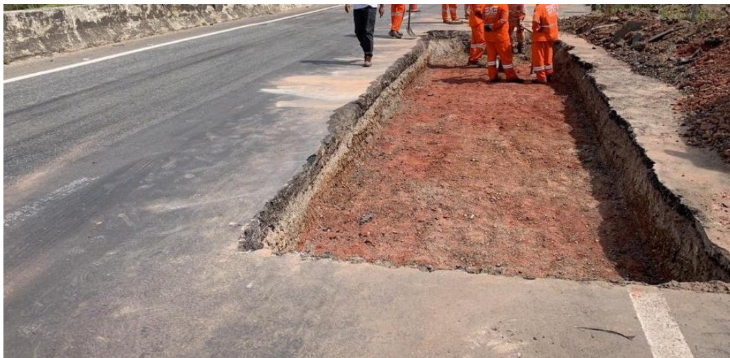
Figura 18: Remendo profundo
