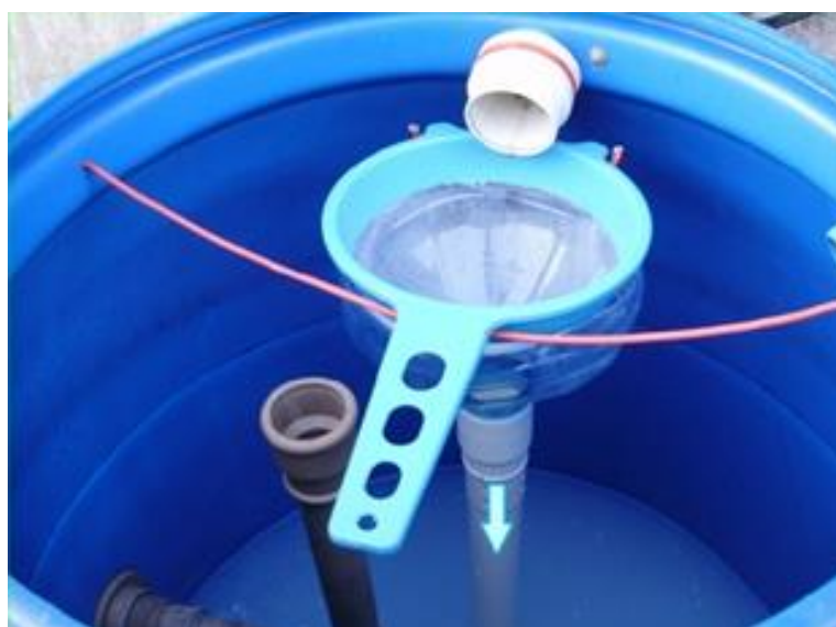
Figura 08: Reservatório com processo de filtração
