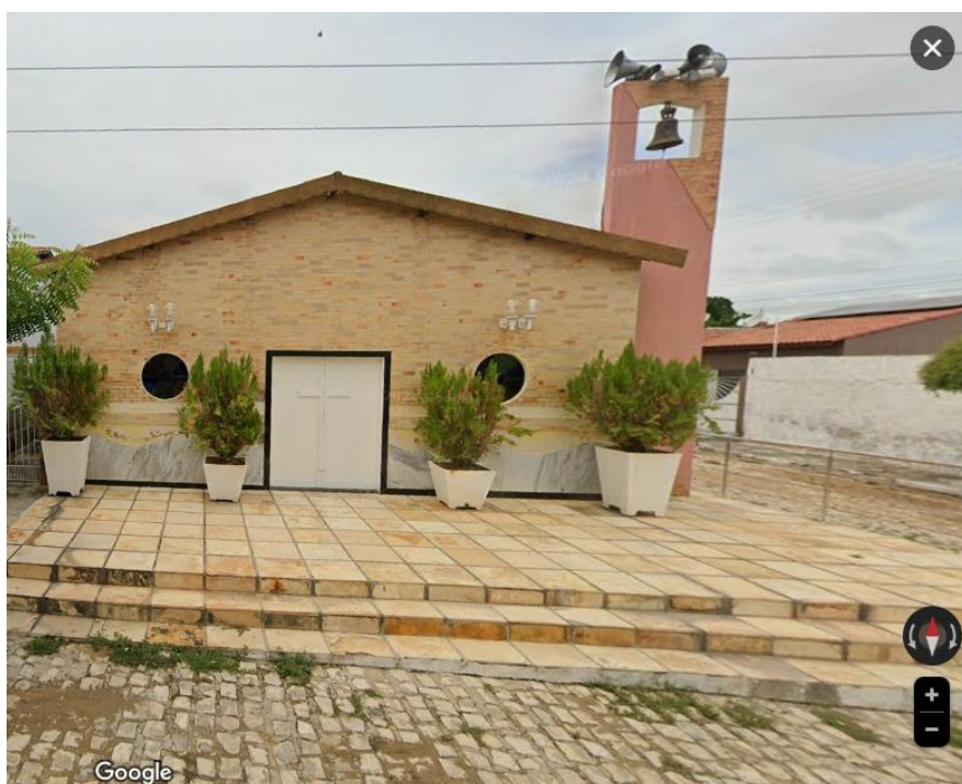
Figura 24 - Fachada frontal da igreja.
