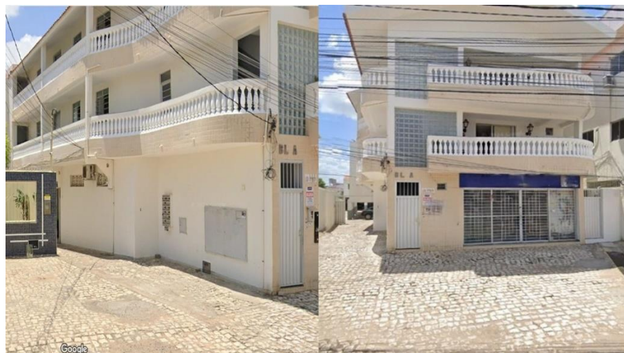
Figura 22 - Fachada frontal e lateral do prédio.
