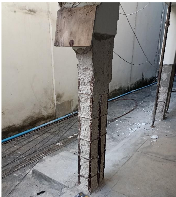
Figura 36 - Corrosão uniforme ao longo de toda superfície do aço.
