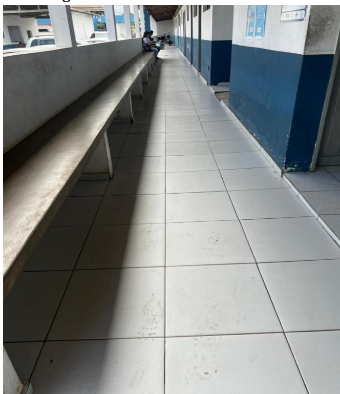
Quadro 6: Dados arquitetônicos do corredor lateral da UBS 1.
