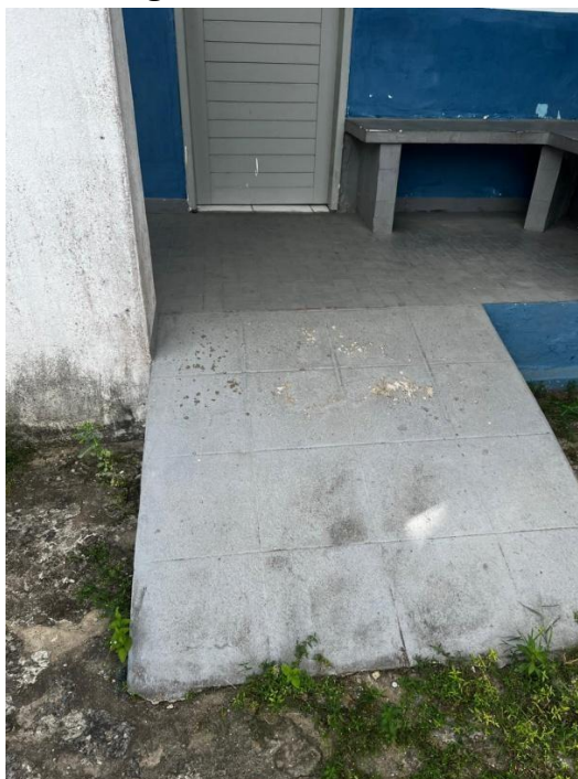
Quadro 7: Dados arquitetônicos da rampa posterior da UBS 2.
