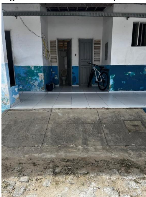
Quadro 4: Dados arquitetônicos da rampa que dar acesso a UBS 1.
