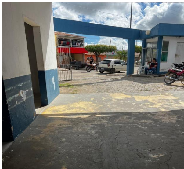
Figura 16- Entrada da UBS 1
