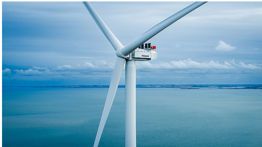
Figura 17 - Aerogerador modelo V236-15.0 MW™ da fabricante Vestas.
