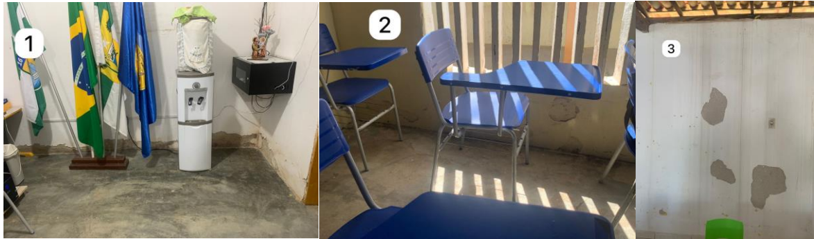
Figura 15- (1) Imagem de deslocamento na recepção. (2) e (3) Salas de aula
