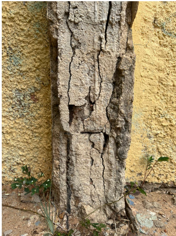
Figura 21 - Pilar escolhido para realização do teste de carbonatação
