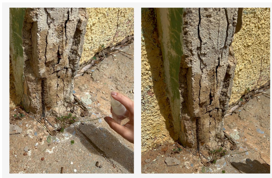
Figura 22 - Pilar Carbonatado
