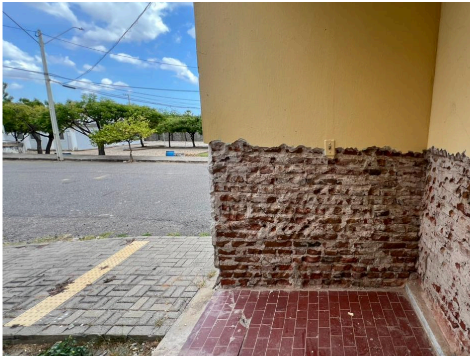
Figura 13 - Alvenaria de vedação - Tijolo cerâmico comum
