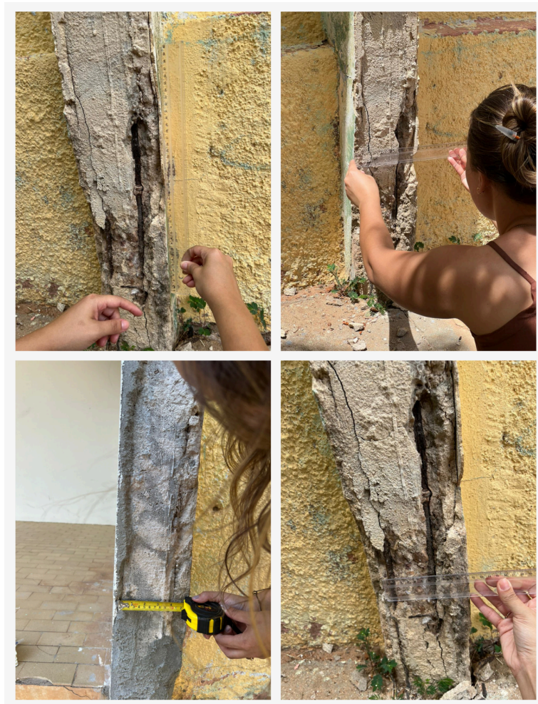
Figura 12 - Medições dos pilares
