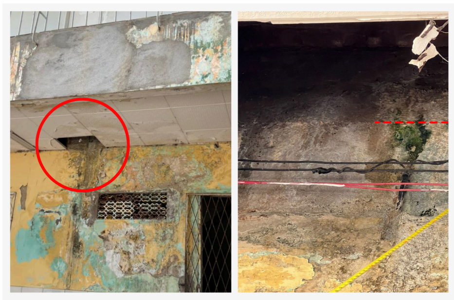
Figura 14 - Viga concretada em duas etapas
