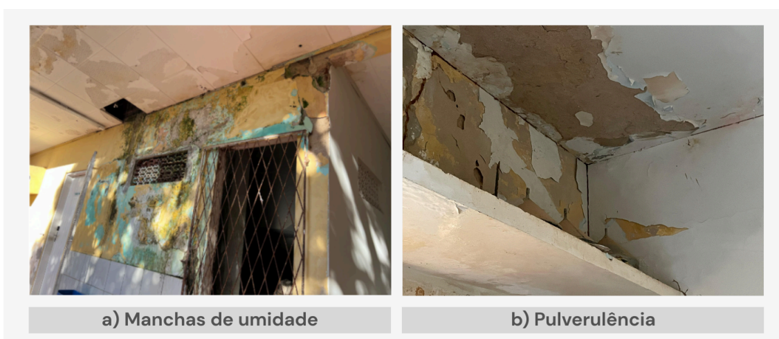
Figura 2 - Manifestações patológicas por umidade
