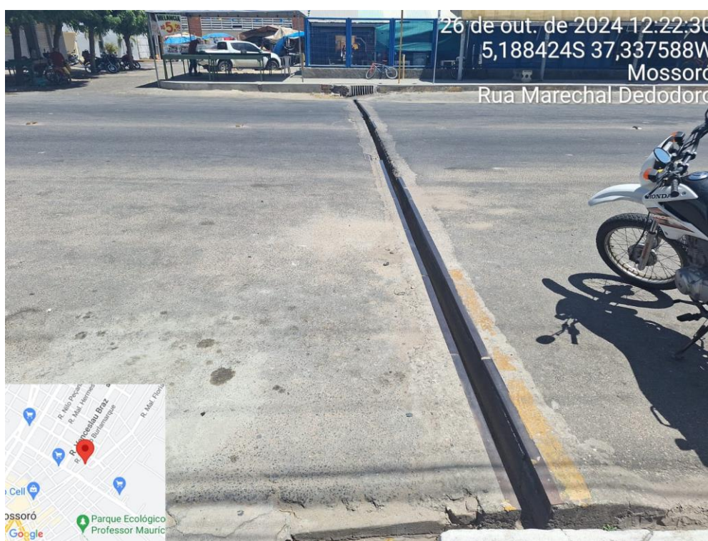
Figura 18 – Sistema de drenagem no ponto de exutório.
