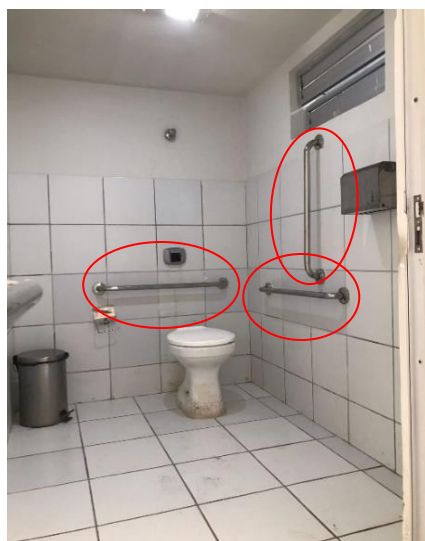
Figura 12: Área interna do banheiro.
