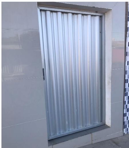
Figura 4: Portão de saída de emergência.
