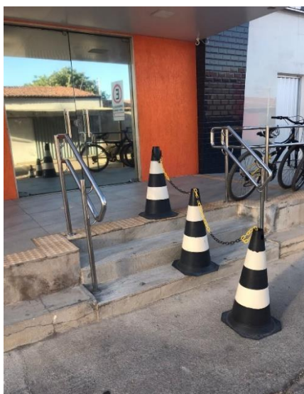
Figura 1: Escadaria de acesso frontal.
