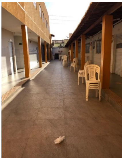
Figura 7: Segunda área de recreação e acesso para as salas.
