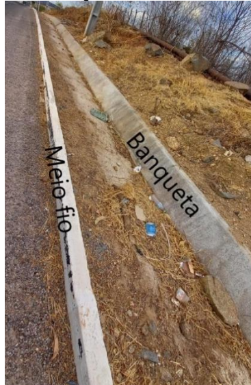
Figura 22: Banqueta e meio fio da rodovia.
