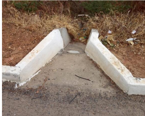
Figura 20: Saída de água executada da rodovia.
