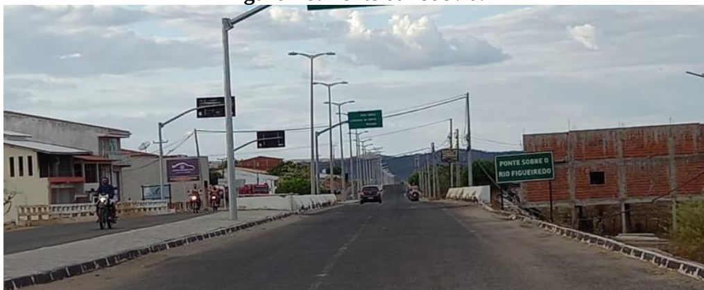
Figura 26: Ponte da rodovia.
