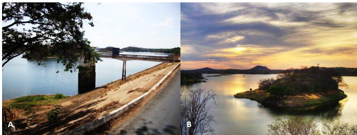
Figura 12 - Vistas (A e B) do açude de São Gonçalo
