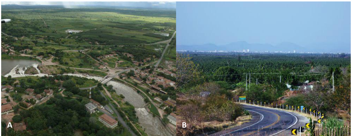
Figura 8 - Vista aérea (A e B) do PISG
