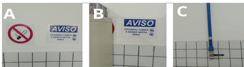
FIGURA 10. Sinalização observadas no laboratório de usinagem da Ufersa: (A) Avisos de proibido fumar, proibido comer e beber nesta área; (B) Aviso de proibido fumar obstruído por um armário; (C) Tubulação pneumática azul indicando o seu fluido de trabalho. Fonte: Dados da pesquisa (2024).
