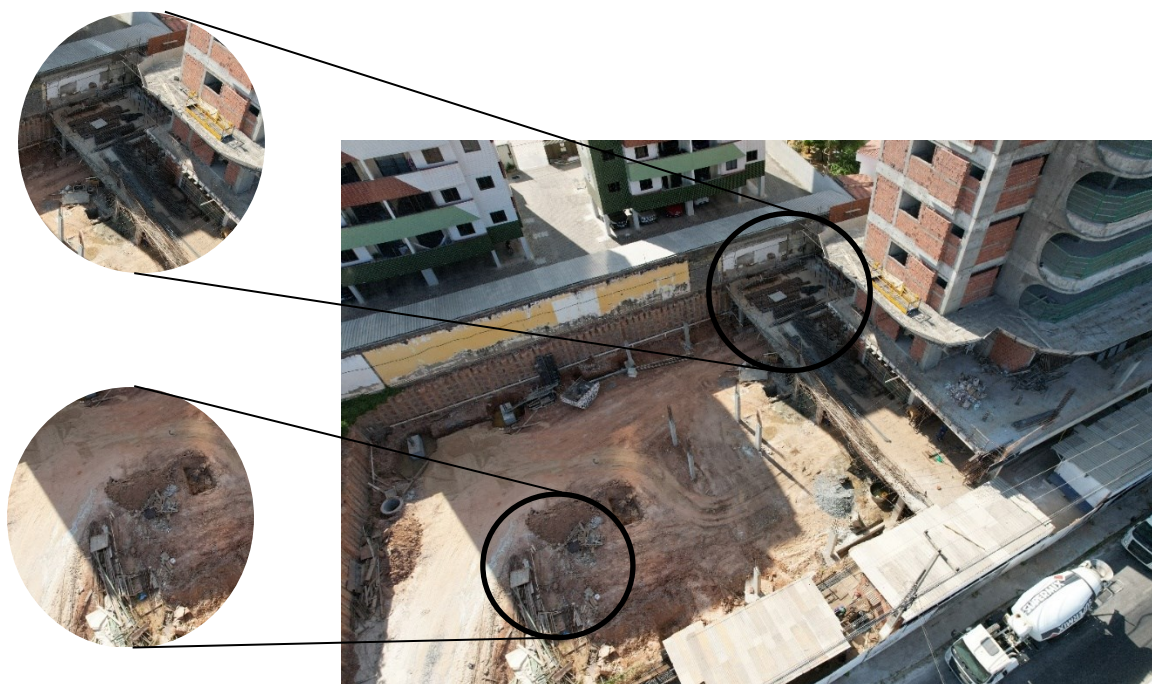
Figura 8. Layout das centrais de aço e carpintaria. Fonte: Autoria própria (2024).
