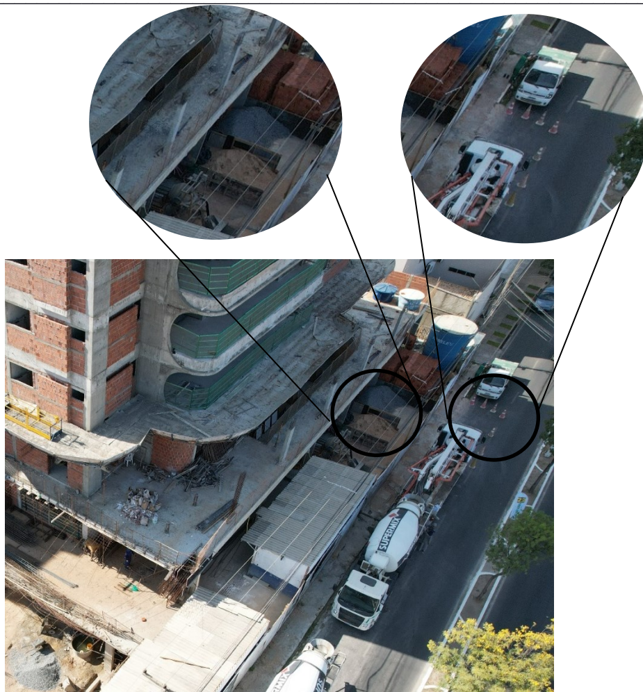
Figura 9. Baias para areia, britas e tijolos. Fonte: Autoria própria (2024).
