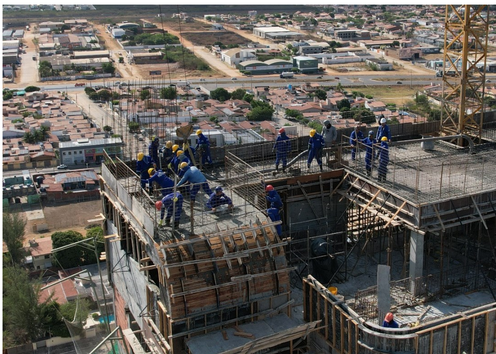
Figura 6. Serviço de concretagem da laje superior. Fonte: Aatoria própria (2024).
