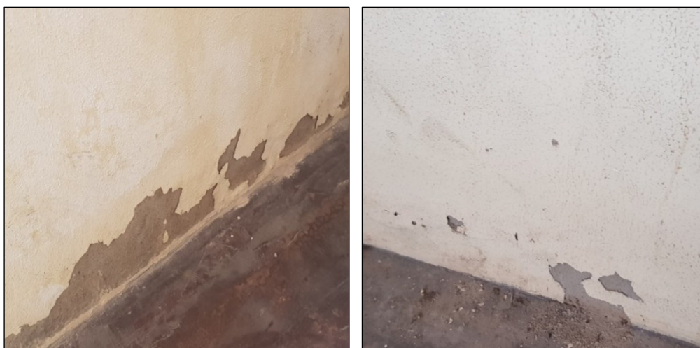
Figura 23 – Descolamento nas paredes internas
