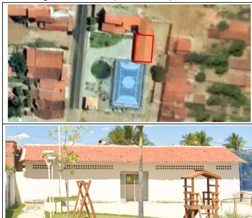
Figura 3 – Localização da edificação do estudo
