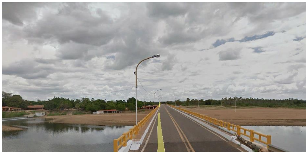
Figura 3 – Vista de cima da ponte sobre o Rio Jaguaribe.
