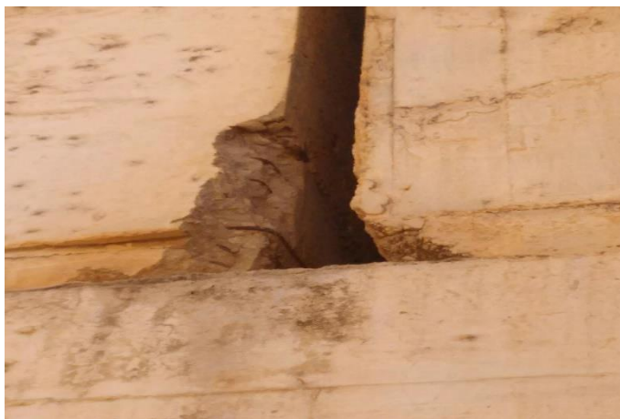
Figura 14 – Junta de dilatação 2.
