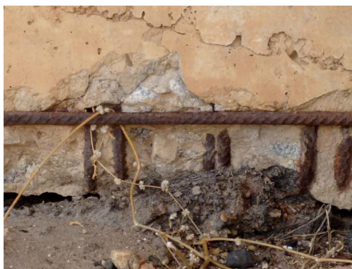
Figura 7 – Estrutura de encontro do talude.
