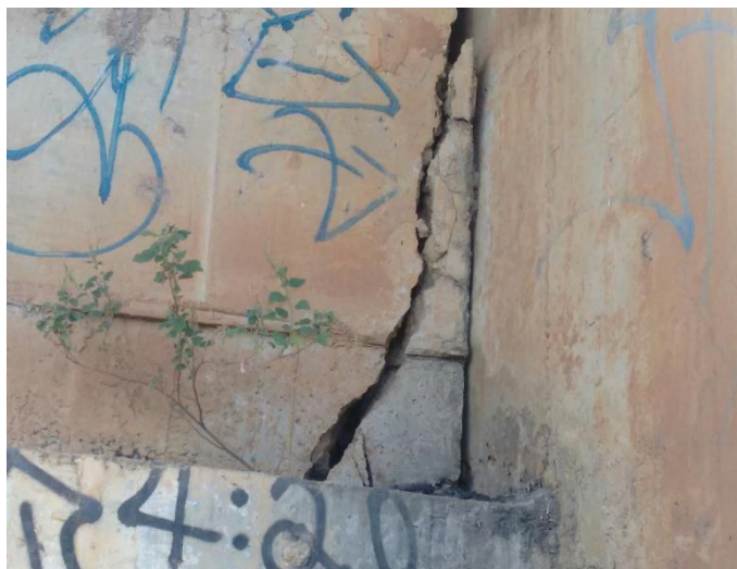
Figura 16 – Junta de dilatação 6.
