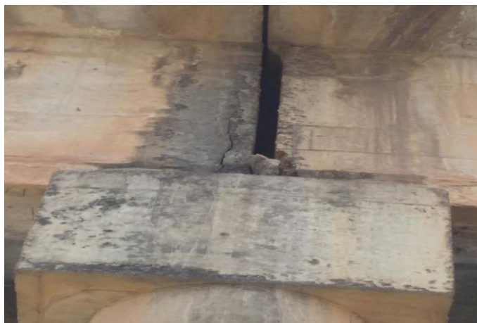
Figura 15 – Junta de dilatação 5.
