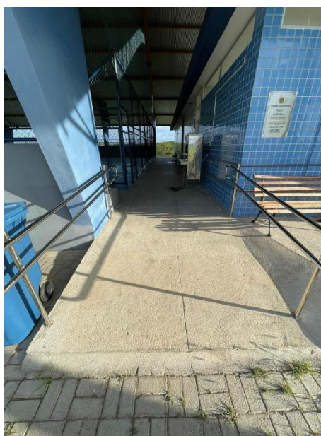
Figura 33 – Rampa frontal de acesso ao ginásio
