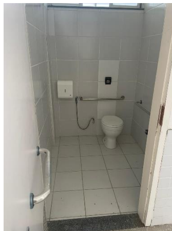
Figura 28 – Interior do banheiro acessível
