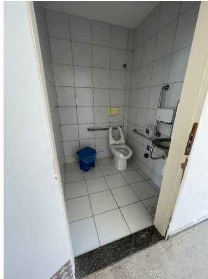
Figura 19 – Detalhe do interior do Banheiro acessível
