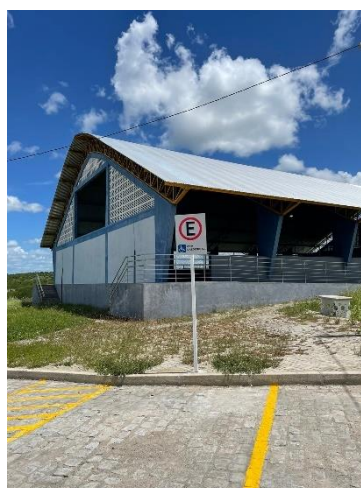
Figura 30 – Vista frontal do ginásio poliesportivo
