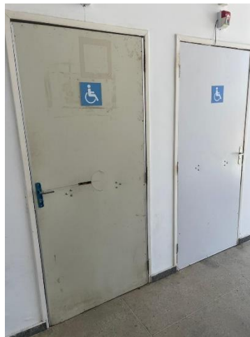
Figura 18- Detalhe das Portas dos Banheiros acessíveis
