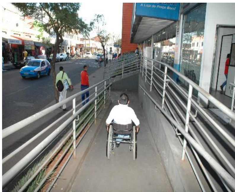
Figura 9: Rampa de acesso ao terminal central na cidade de Uberlândia – MG.
