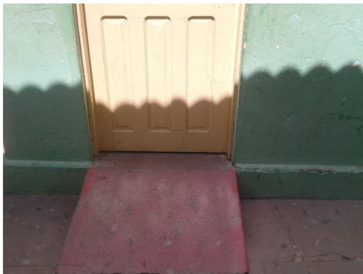
Figura 26: Rampa no acesso às salas de aula.
