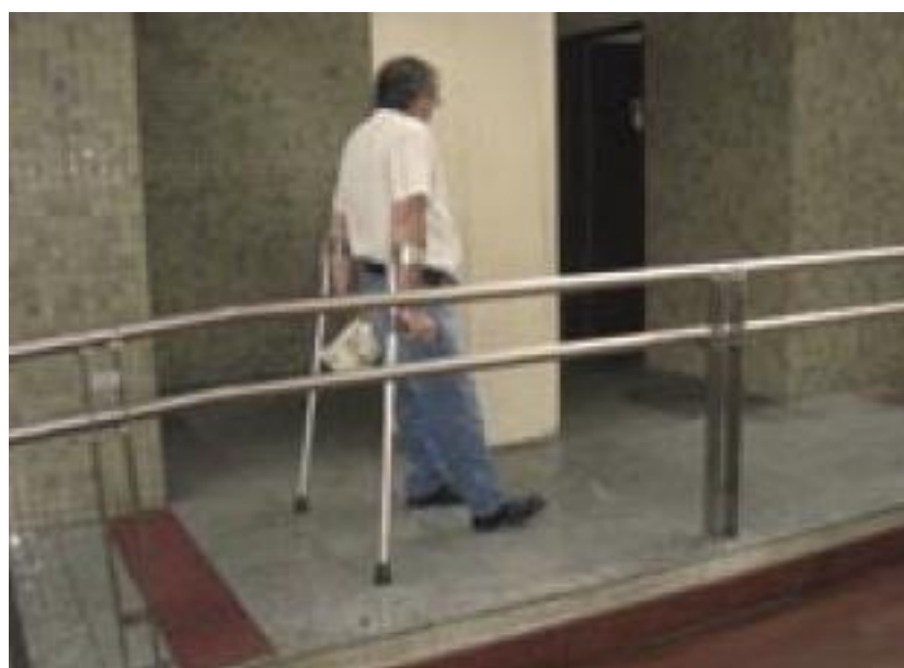
Figura 8: Usuário de muletas acessando edificação com rampa adequada com corrimão em alturas corretas.
