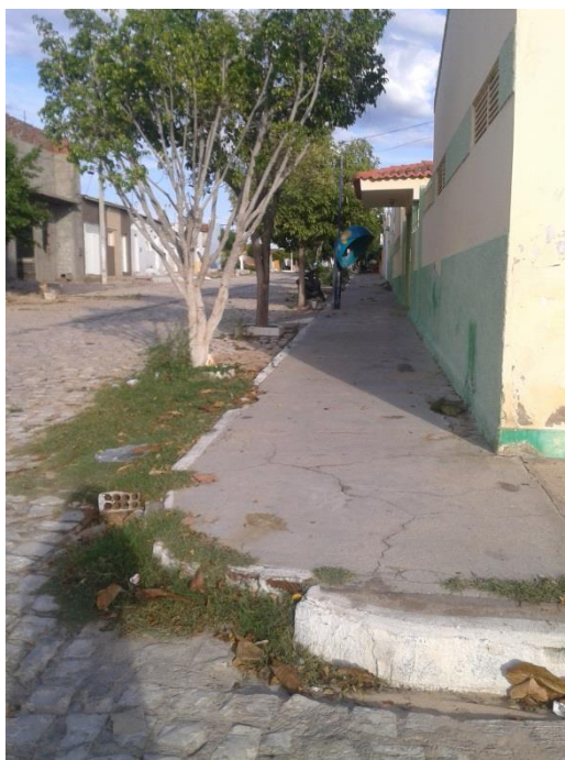
Figura 13: Esquina sem rebaixamento.
