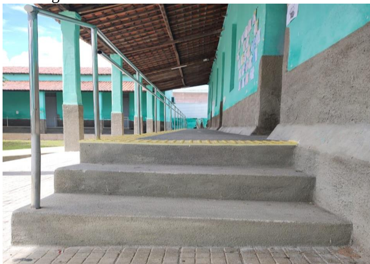
Figura 12 - Acesso a salas de aula do Bloco A
