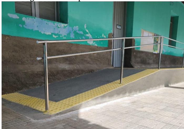
Figura 13 - Rampa de acesso salas de aula
