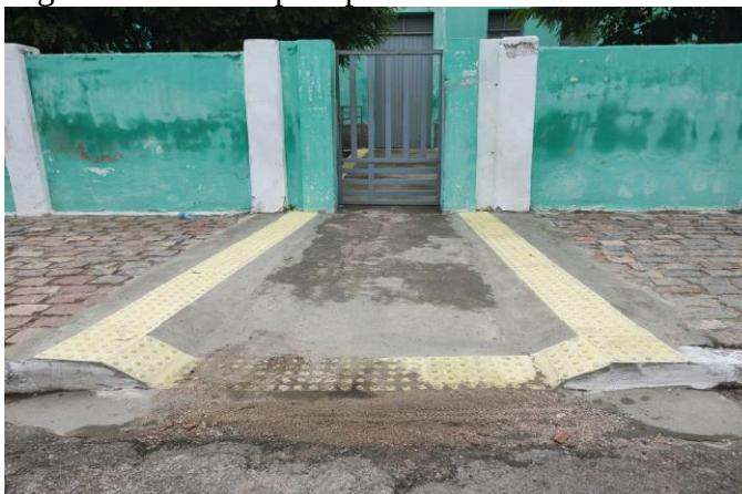
Figura 8 - Entrada pelo portão de acesso ao Bloco A
