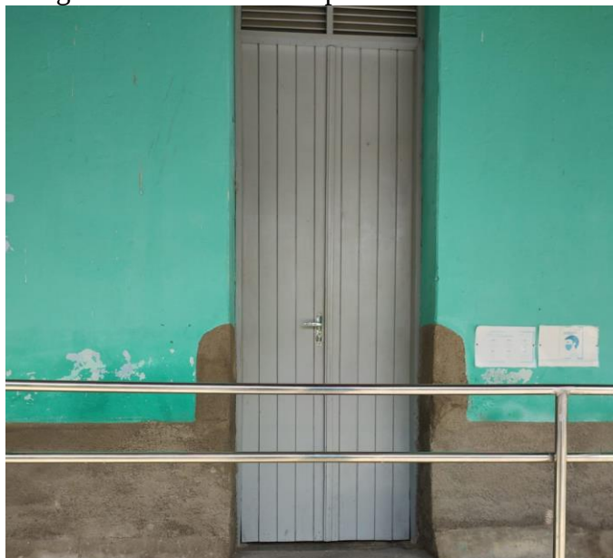
Figura 15 - Aberturas de portas das salas de aula
