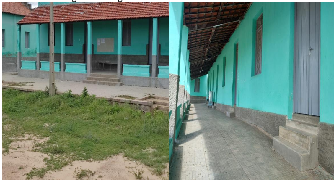
Figura 24 - Segundo acesso as salas de aula do Bloco B
