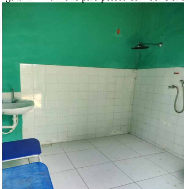
Figura 17 - Banheiro para pessoa com deficiência
