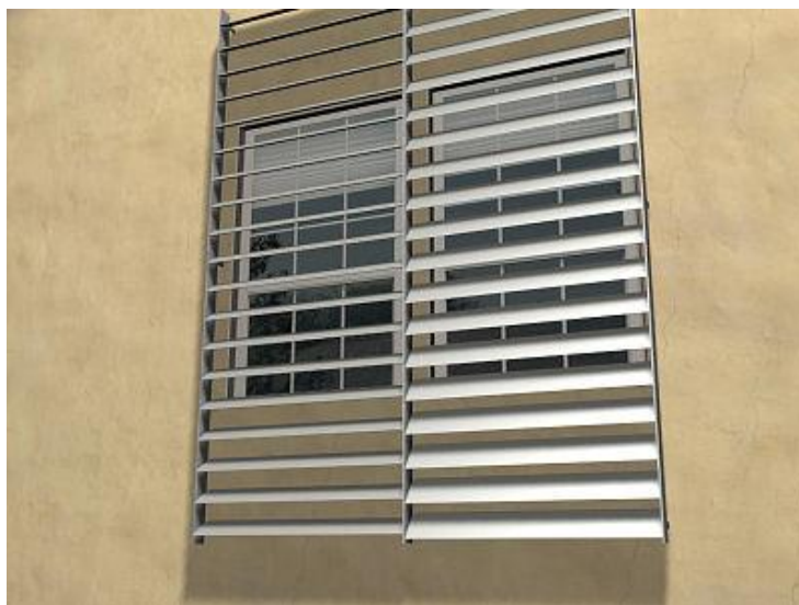
Figura 19: Proteção de brises de PVC.
