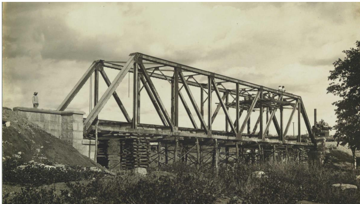
Figura 8: Ponte em construção entre o trecho Lavras – Aurora, CE (1920).
