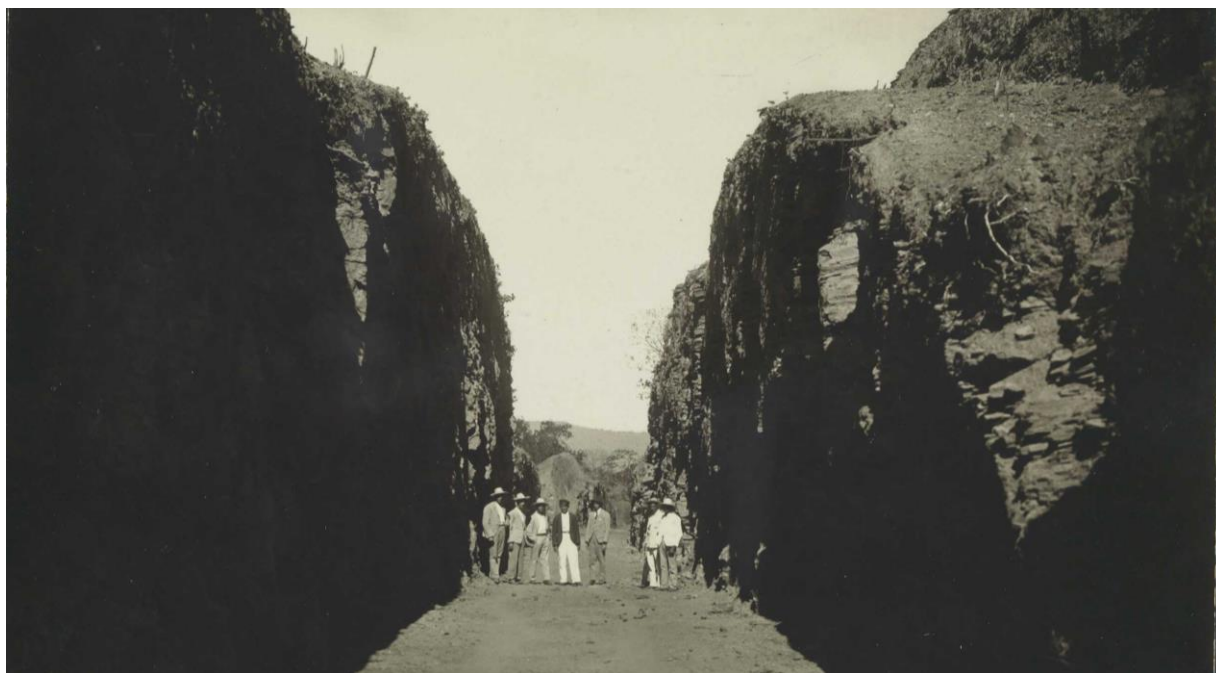
Figura 10: Corte em Rocha no Trecho Lavras - Aurora.
