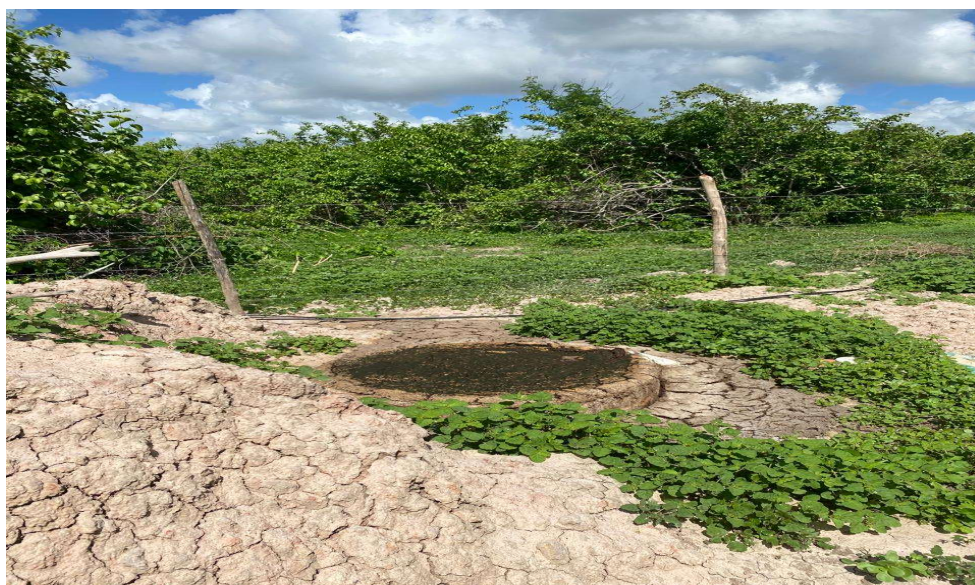
Figura 8 – Tanque do resíduo final do processo do biodigestor do Projeto Comunidades Vivas na comunidade Poço da Onça em Quixeré – CE.
