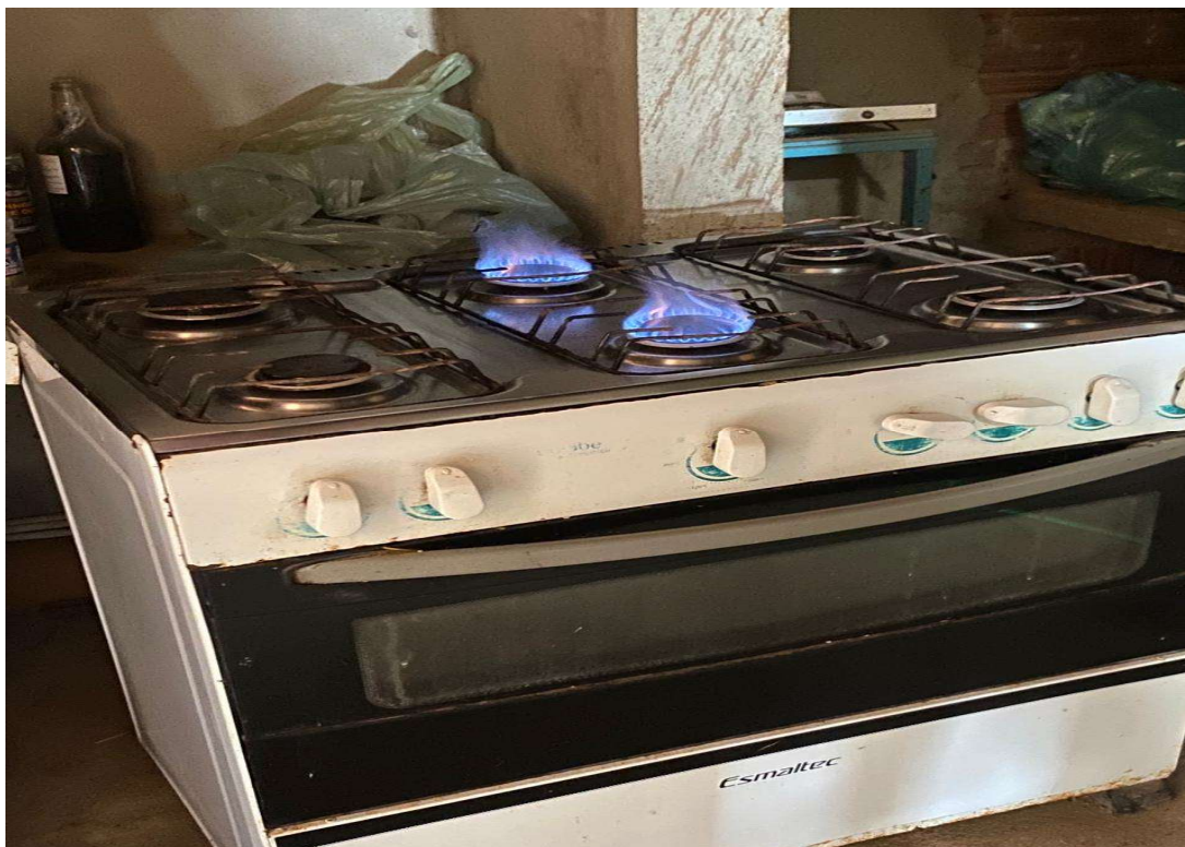
Figura 9 – Identificação, no fogão, da saída do gás metano, produto proveniente dos dejetos dos bovinos pela instalação do biodigestor do Projeto Comunidades Vivas na comunidade Poço da Onça em Quixeré – CE.
