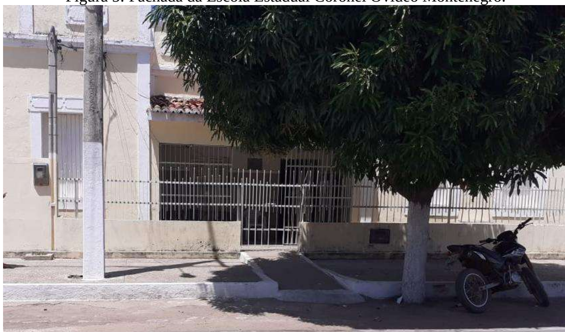
Figura 5: Fachada da Escola Estadual Coronel Ovídeo Montenegro.
