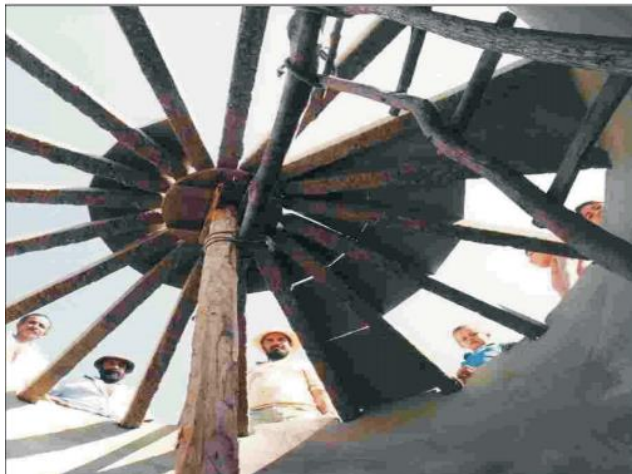
Figura 4: Vista interior da montagem do teto da cisterna.
