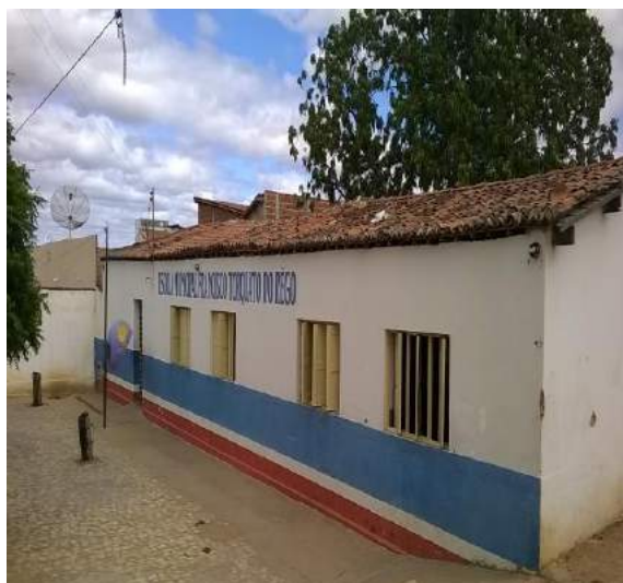
Figura 28: Escola de nível fundamental da comunidade do São Geraldo
