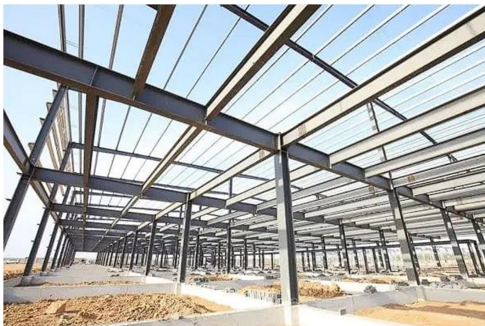
Figura 143 - Exemplo de estrutura metálica.
