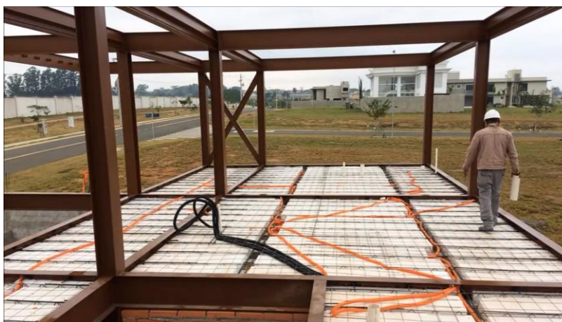
Figura 116 - Laje de EPS em estrutura metálica.
