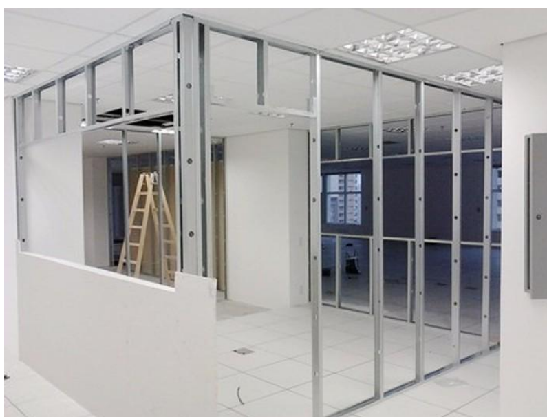
Figura 124 - Construção em drywall
