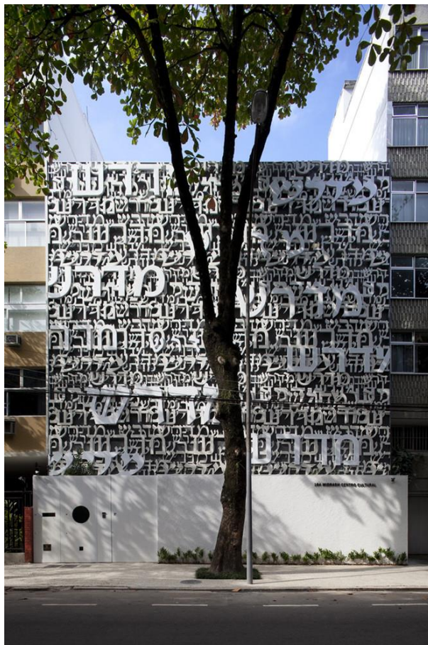
Figura 60 - Vista da fachada principal do Centro Cultural Midrash
