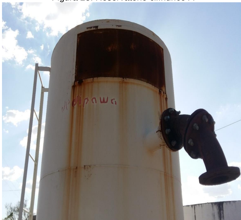
Figura 28: Reservatório cilíndrico A
