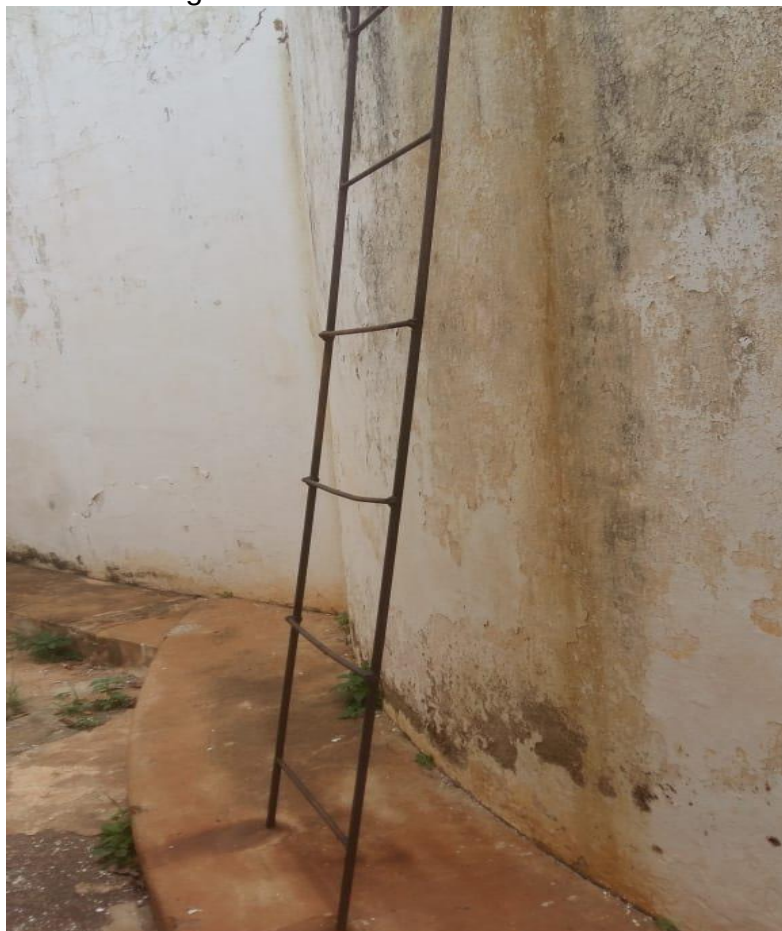
Figura 23: Escada do reservatório
