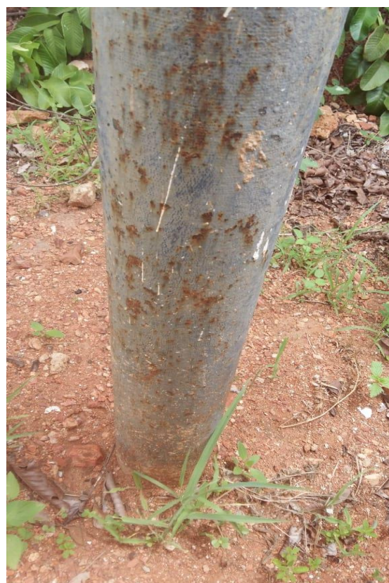
Figura 16: Tubulação de ferro fundido B
