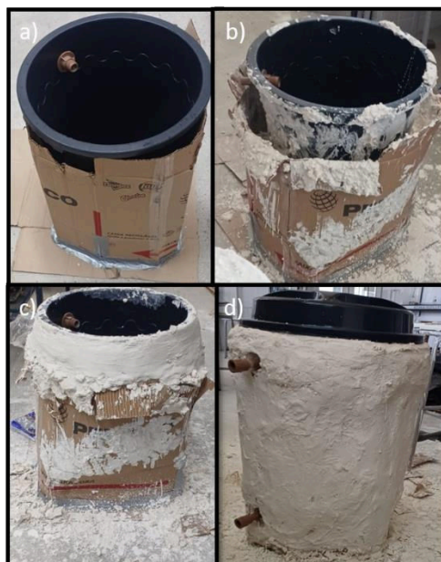
Figura 17: Etapa de isolamento do reservatório: (a) confecção do molde, (b) início do isolamento térmico, (c) final do isolamento, (d) reservatório totalmente isolado.
