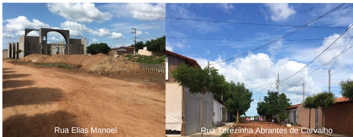
Figura 11: Infraestrutura das ruas: Elias Manoel e Terezinha Abrantes de Carvalho.
