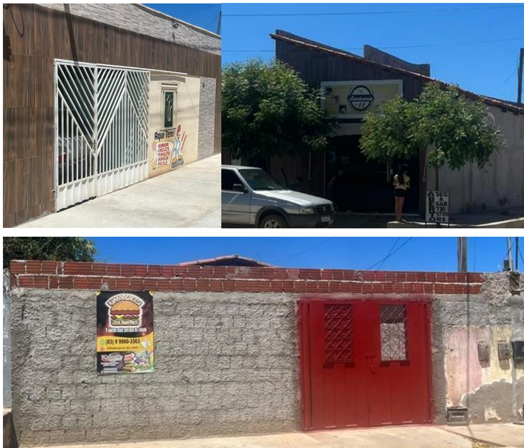
Figura 23: Tipologias de algumas residências encontradas no bairro.
