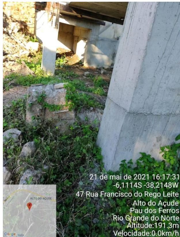
Figura 7 - Construção de Alvenaria no Vertedouro do Açude
