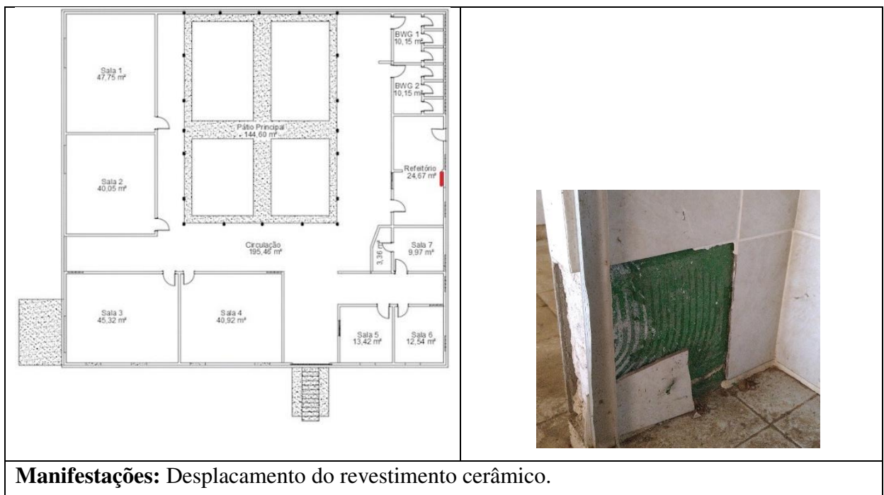
Quadro 4: Localização de deslocamento do revestimento cerâmico
