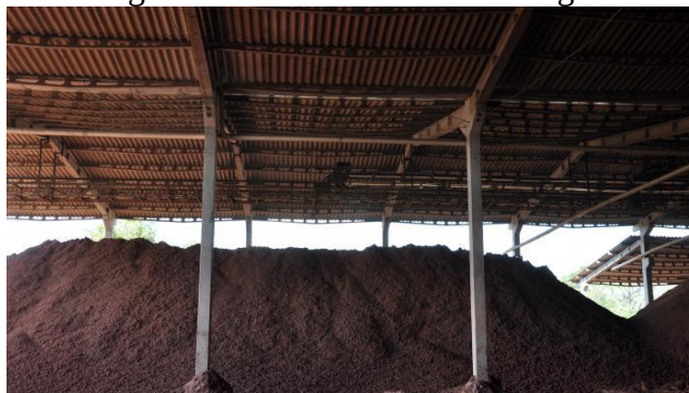
Figura 6 – Armazenamento da argila
