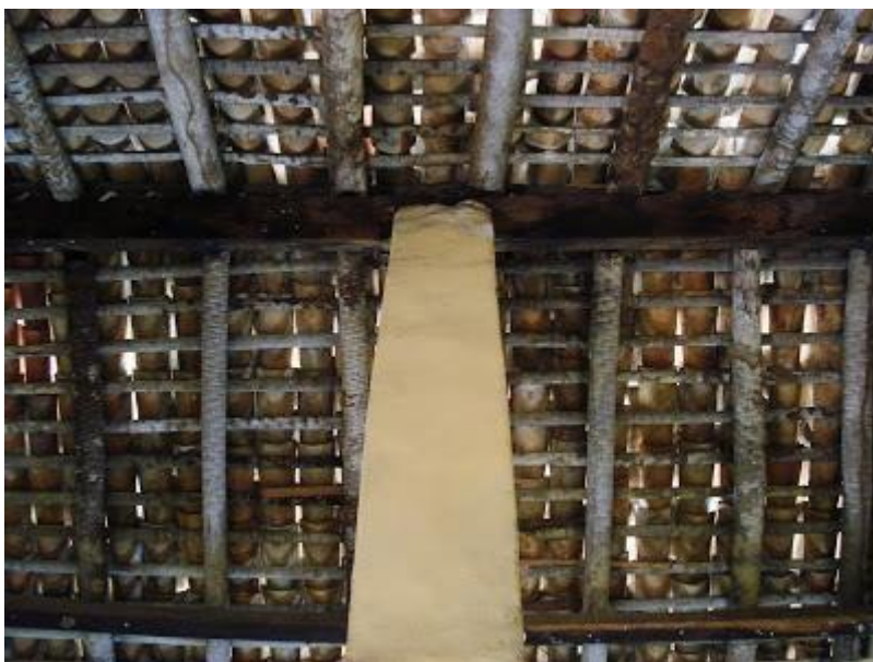
Figura 6. Detalhe do uso da carnaúba em tetos: ripas, caibros e vigas em casas piauienses. (foto: Kaki Afonso. Campo Maior: abril 2009)
