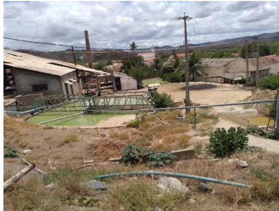
Figura 14 - Reservatório denominado como espaçador
