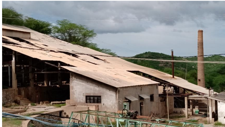
Figura 29 - Exterior do antigo engenho da Mina
