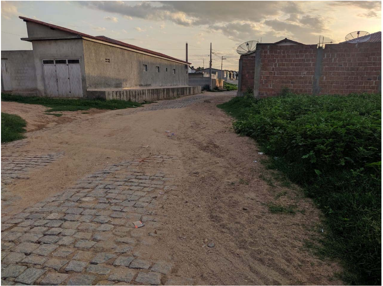
Figura 4 – Acumulo de matérias em via pública deixados pela chuva
