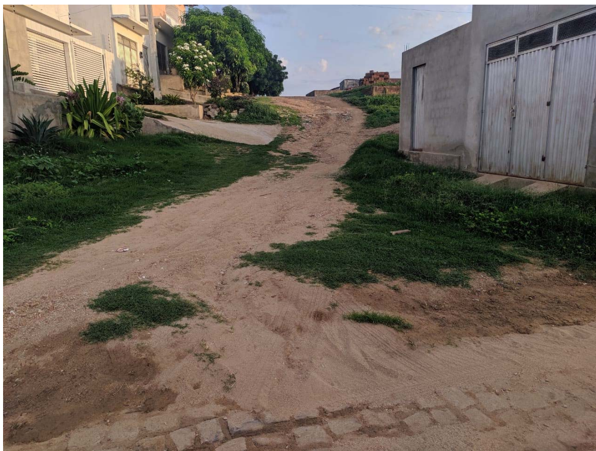
Figura 2 – Via pública desviada por locação errada
