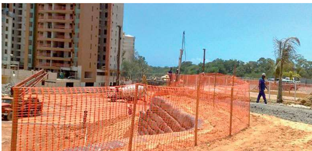
Figura 9 - Redes de Proteção para Segurança e Tapume
