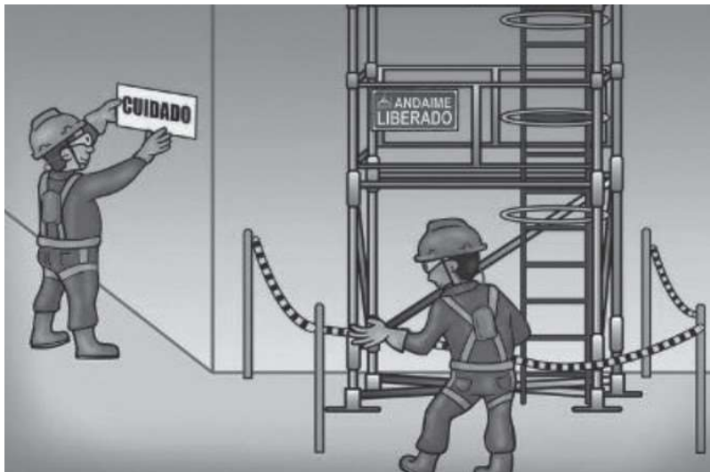
Figura 5 - Isolamento de Área com Sobreposição de Trabalhadores
