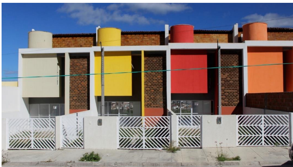
Figura 39 - Perspectiva das frontais dos sobrados
