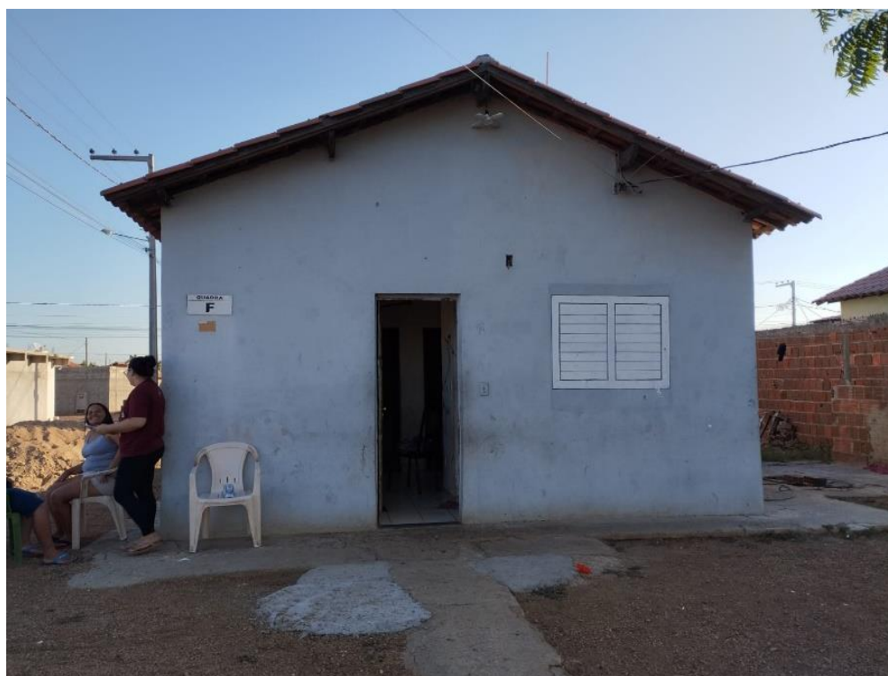
Figura 34 - Imagem da fachada da moradia original
