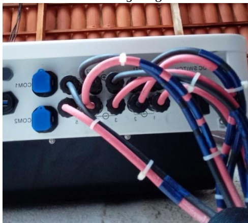
Figura 9 - Terminais das strings ligados de forma invertida.
