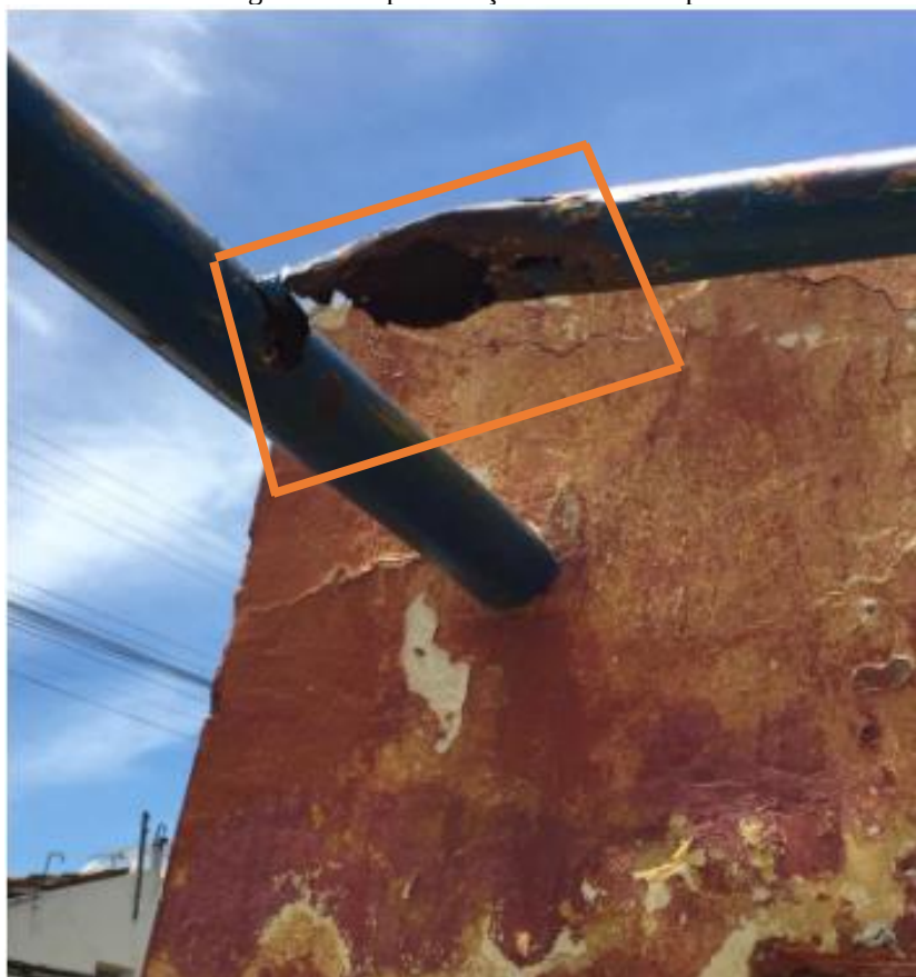
Figura 19: Representação de Corrosão por Frestas
