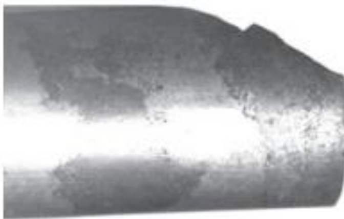
Figura 10: Caracterização de corrosão dezincificada
