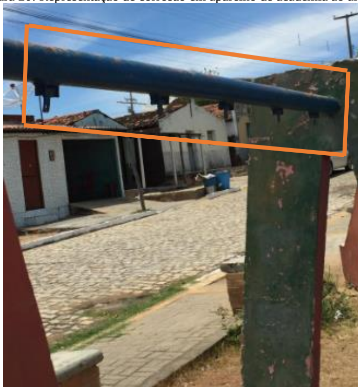
Figura 20: Representação de corrosão em aparelho de academia ao ar livre
