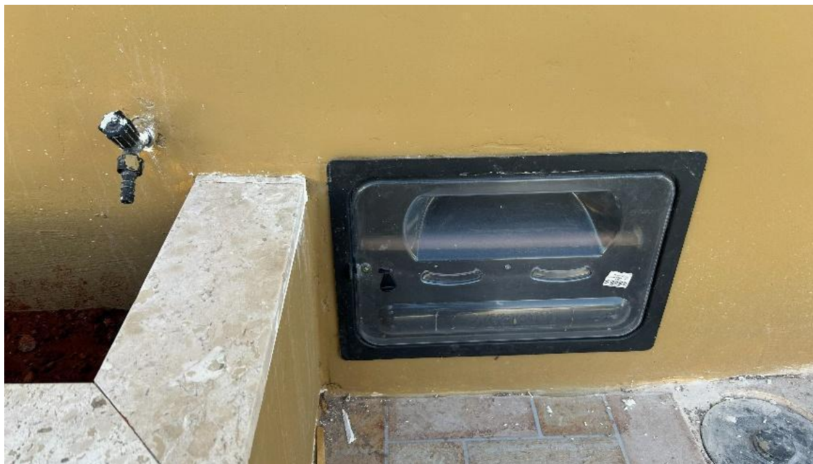
Figura 11 – Cavalete finalizado à espera da CAERN para instalação do hidrômetro
