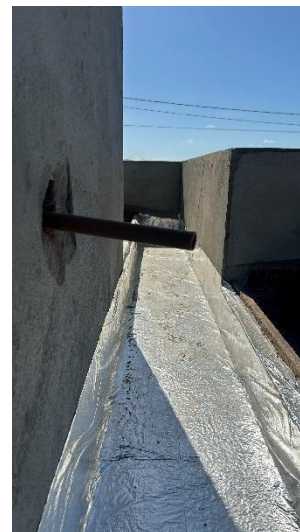
Figura 26 – Saída do extravasor na calha
