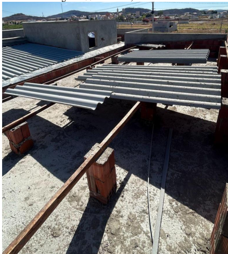
Figura 100 – Telhado, residência A
