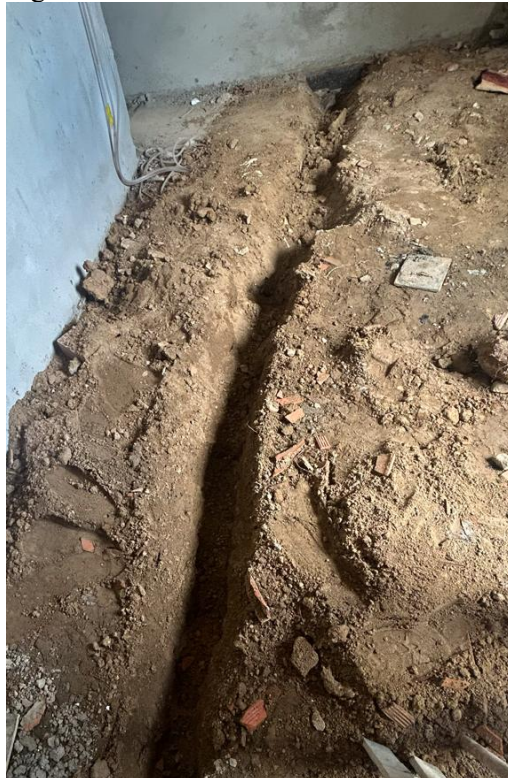
Figura 87 – Vala do sub-coletor da cozinha
