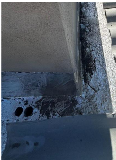
Figura 109 – Tubulação de queda
