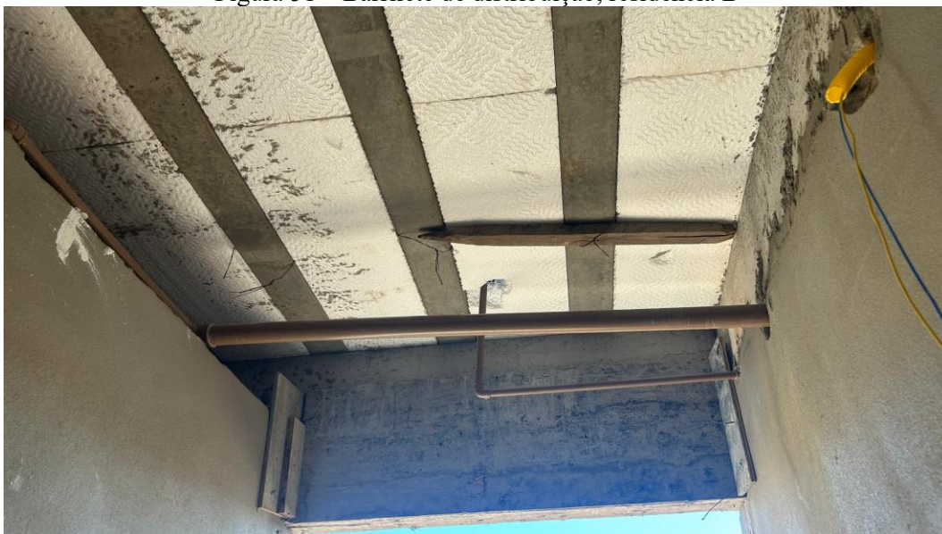
Figura 51 – Barrilete de distribuição, residência B
