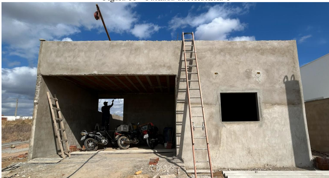
Figura 61 – Fachada da residência C
