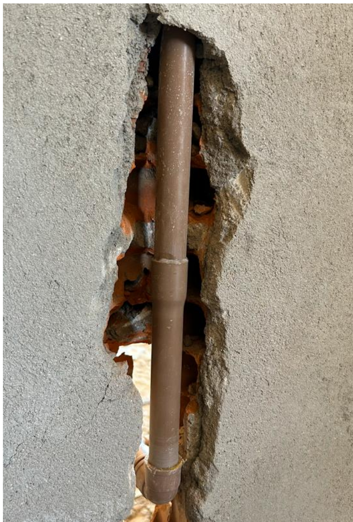
Figura 45 – União da tubulação utilizando a bolsa original do tubo
