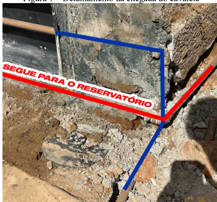
Figura 9 – Detalhamento da chegada do cavalete
