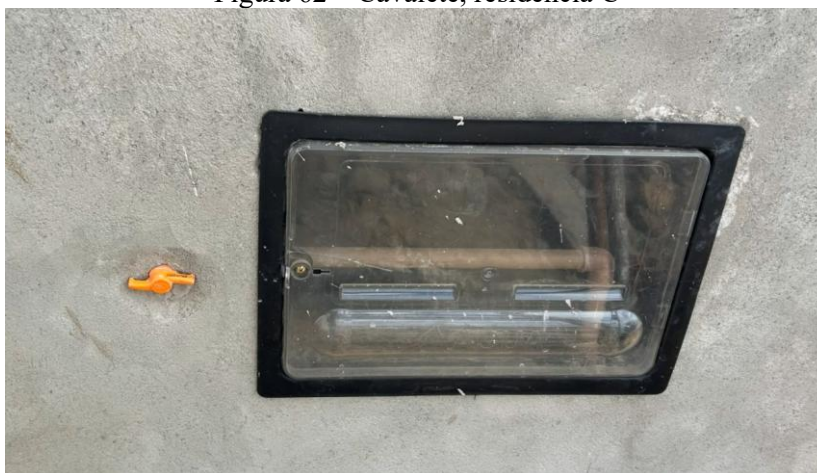
Figura 62 – Cavalete, residência C
