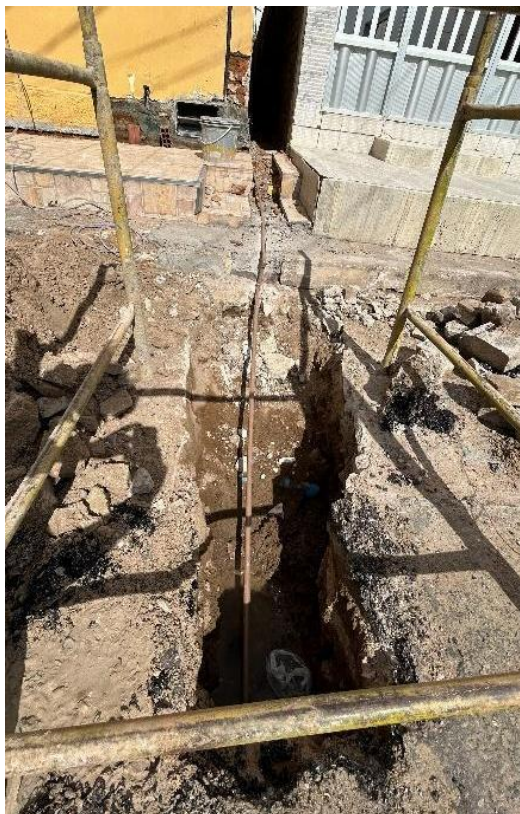
Figura 7 – Ligação com a rede de distribuição
