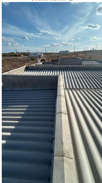
Figura 104 – Telhado garagem, residência B
