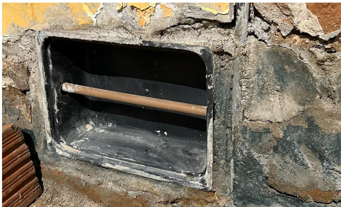
Figura 10 – Cavalete/alimentador predial
