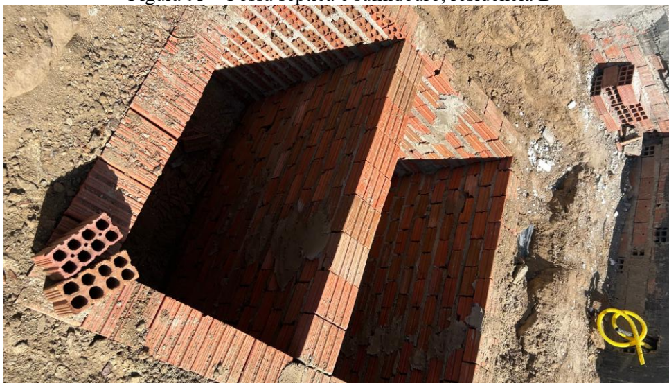
Figura 95 – Fossa séptica e sumidouro, residência B
