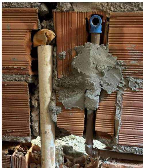
Figura 36 – Ponto da pia, banheiro social
