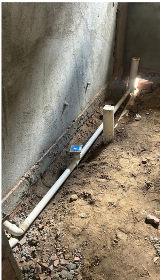
Figura 76 – Instalação de Esgoto Sanitário, banheiro social
