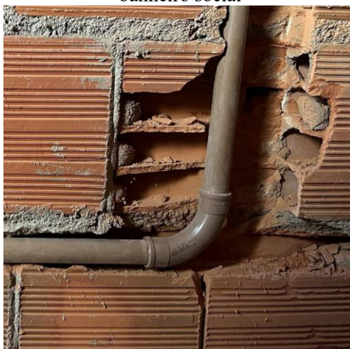
Figura 42 – Curva longa na tubulação do chuveiro, banheiro social, Figura 43 – Curva longa na tubulação do chuveiro, banheiro suíte
