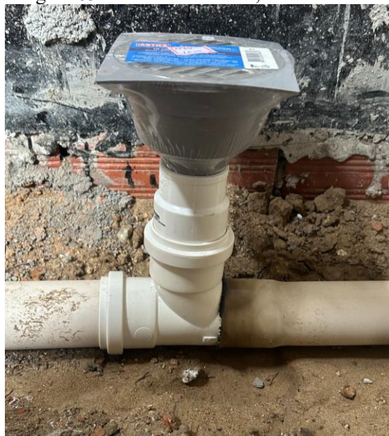
Figura 83 – Ralo fora do box, banheiro suíte
