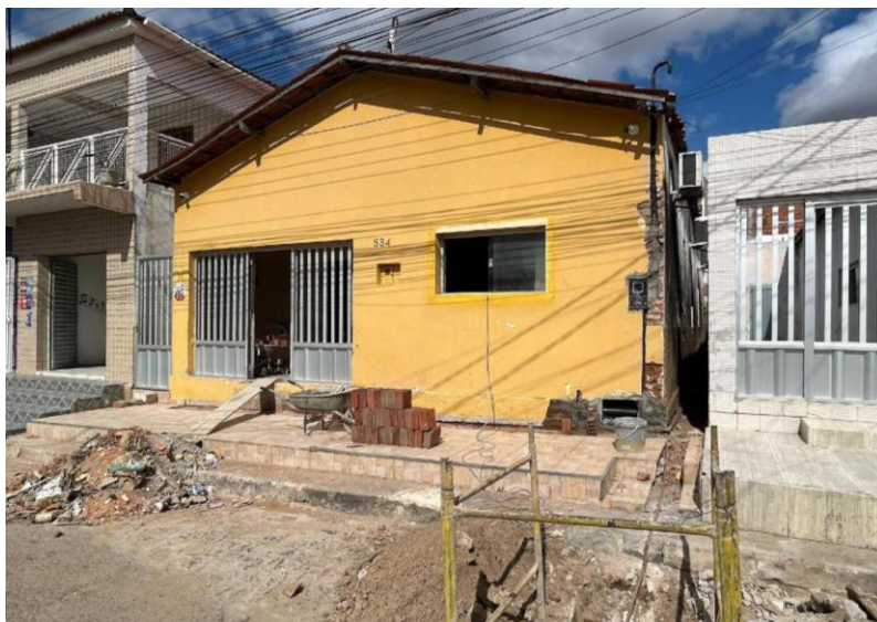
Figura 6 – Fachada da residência em reforma
