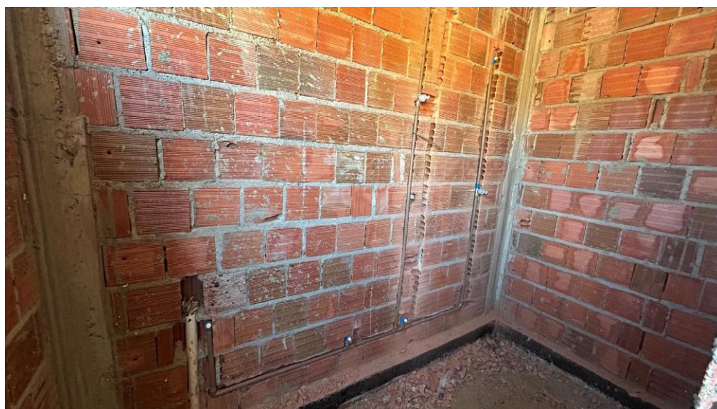
Figura 33 – Instalação de água fria do banheiro suíte
