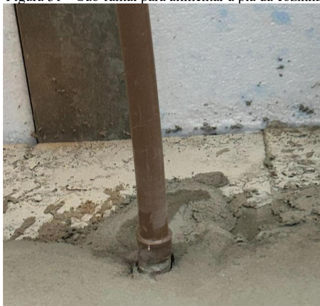
Figura 31 – Sub-ramal para alimentar a pia da cozinha
