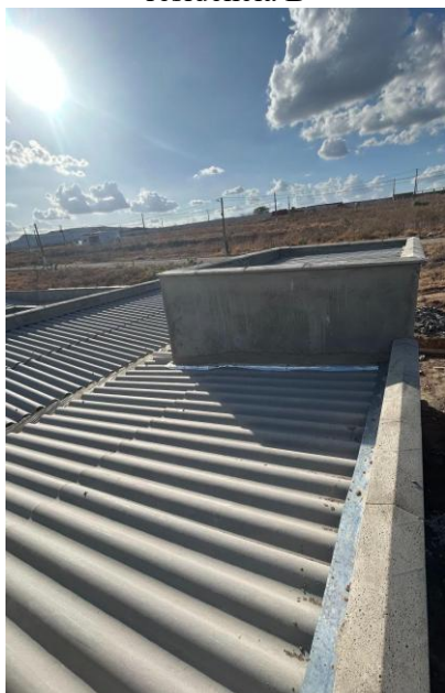
Figura 103 – Telhado geral, residência B
