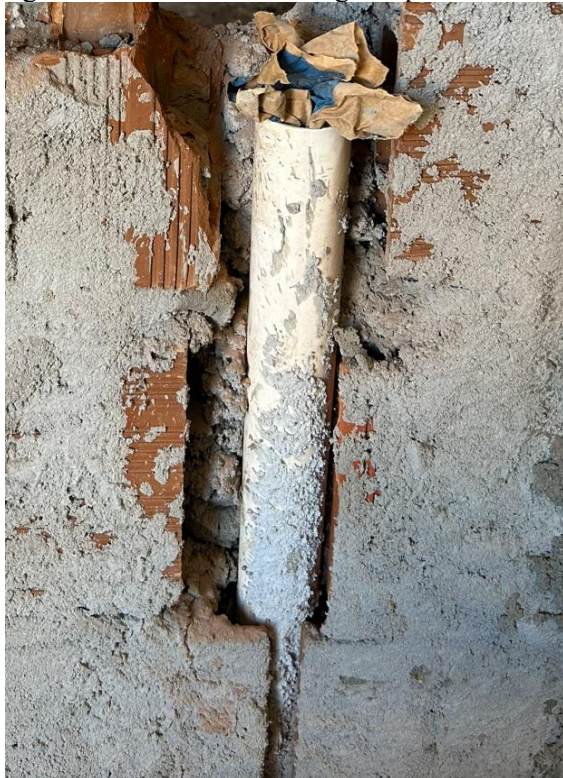
Figura 86 – Ramal de descarga da pia da cozinha
