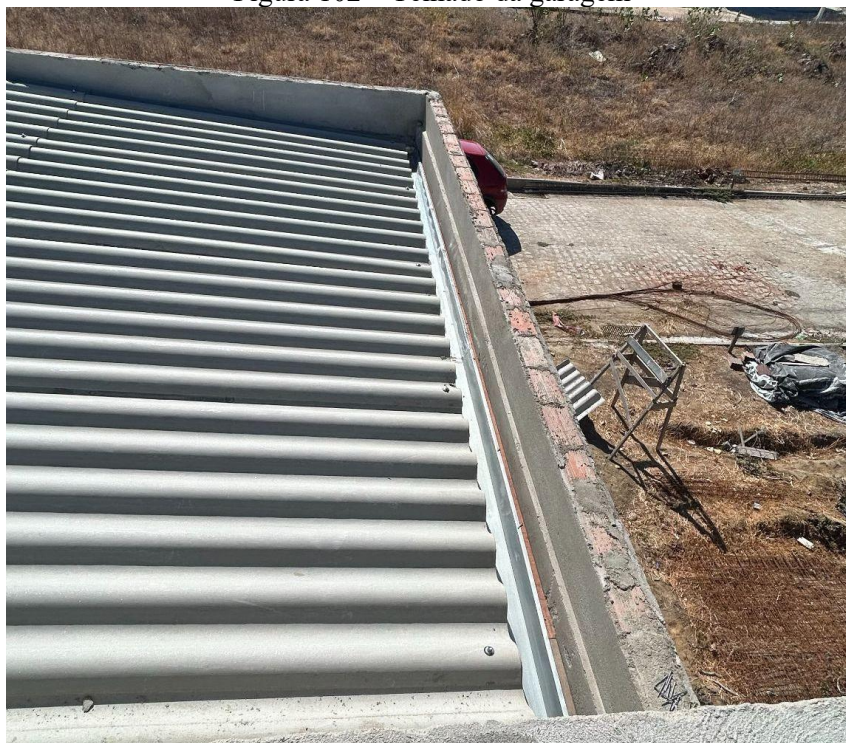
Figura 102 – Telhado da garagem
