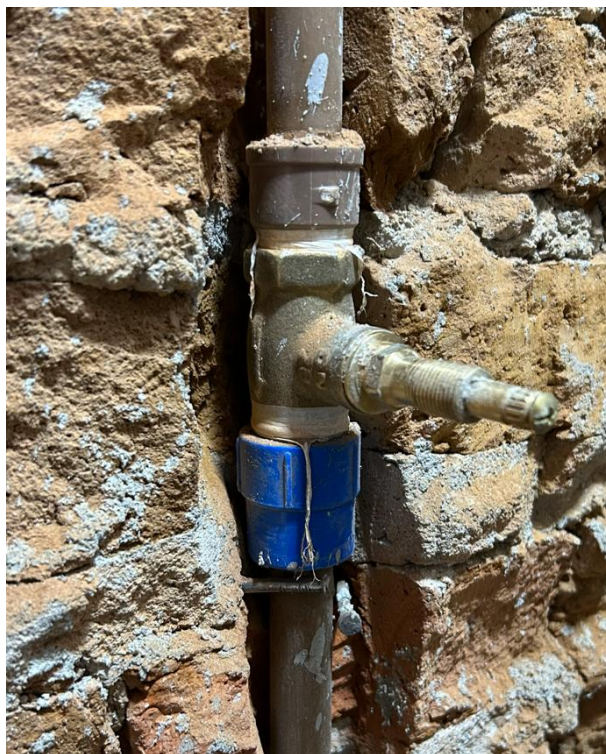
Figura 15 – Válvula do chuveiro
