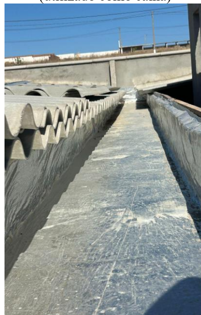
Figura 105 – Manta asfáltica (utilizado como calha)
