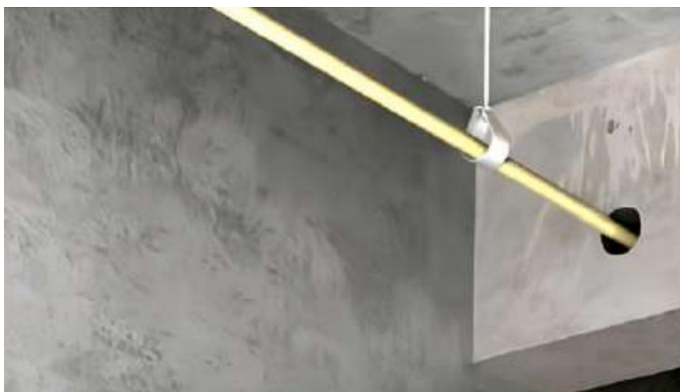
Figura 4 – Passagem por elemento estrutural
