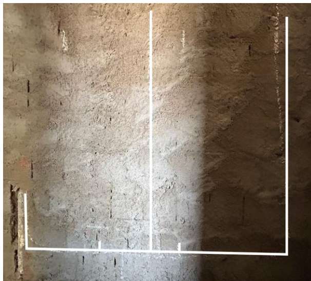
Figura 54 – Traçado realçado sobre a parede, banheiro social residência B
