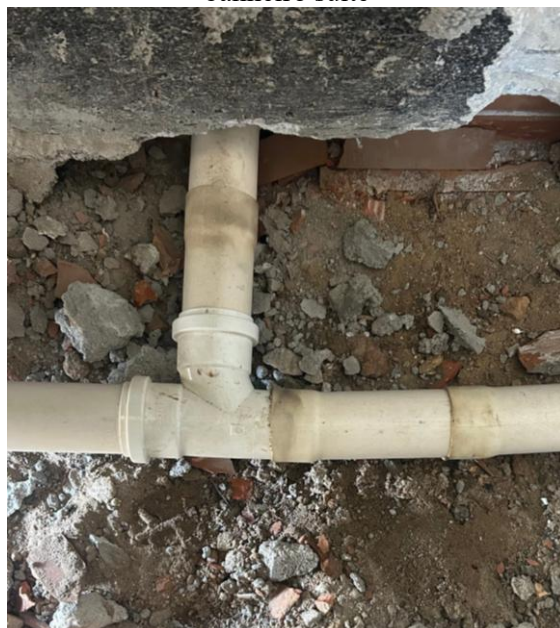
Figura 81 – Curva horizontal da lavatório do banheiro suíte
