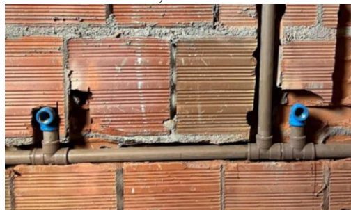
Figura 39 – Ponto da ducha higiênica e vaso sanitário, banheiro suíte
