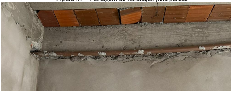
Figura 69 – Passagem de tubulação pela parede
