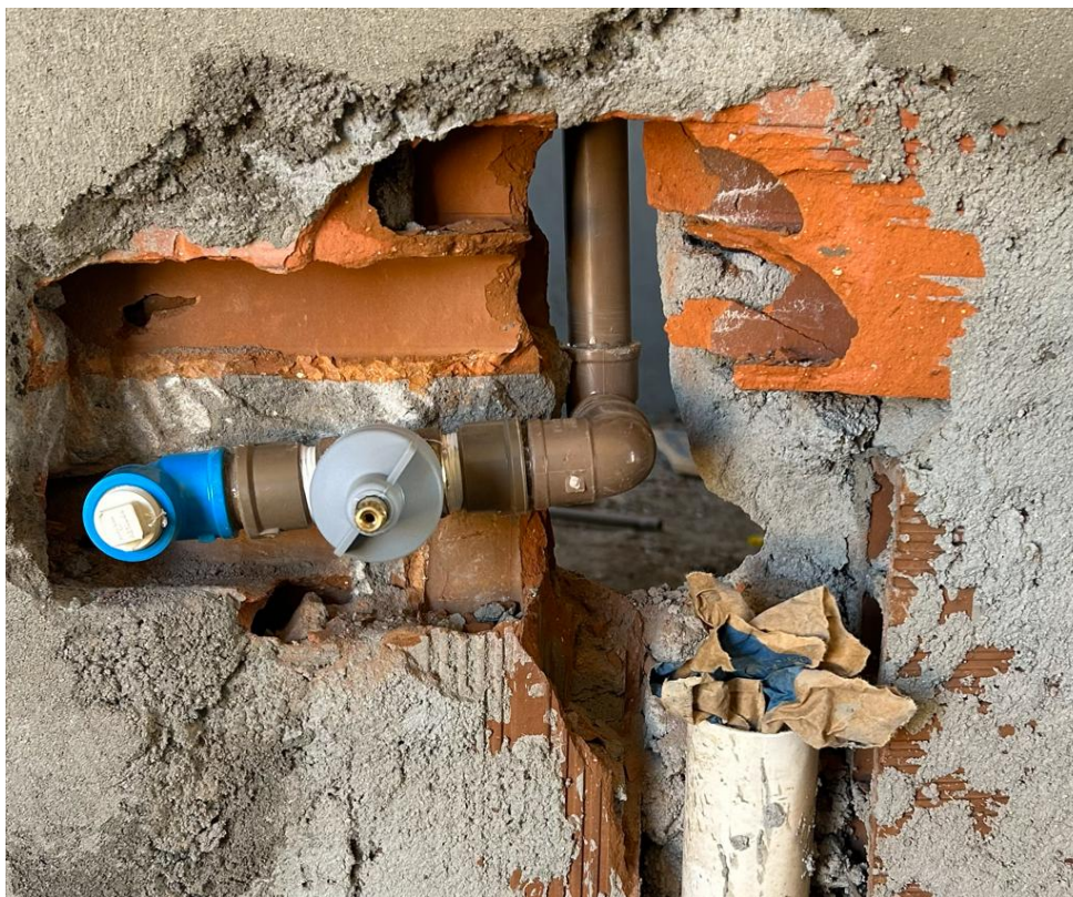
Figura 44 – Ponto de utilização da pia da cozinha
