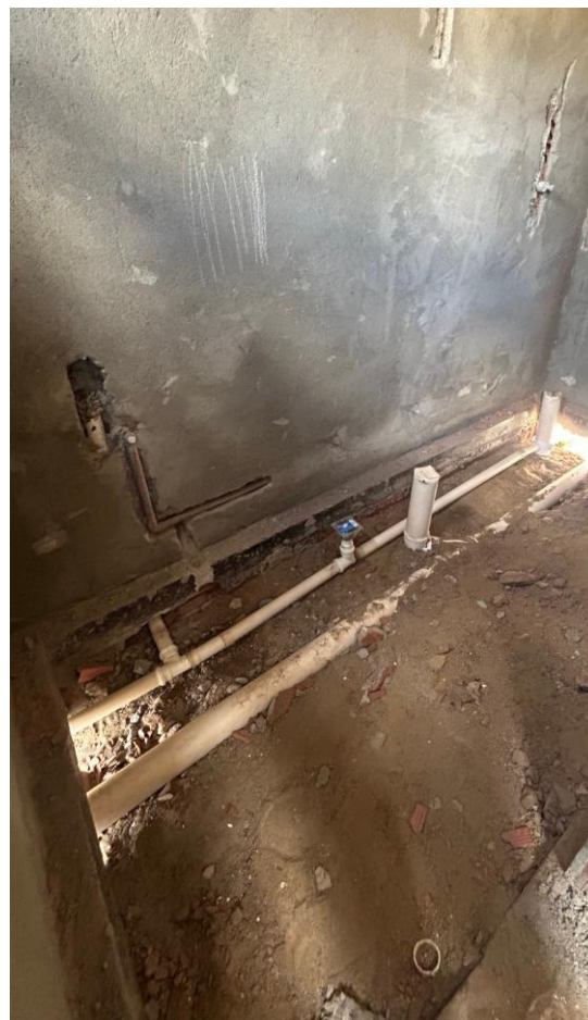
Figura 77 – Instalação de Esgoto Sanitário, banheiro suíte
