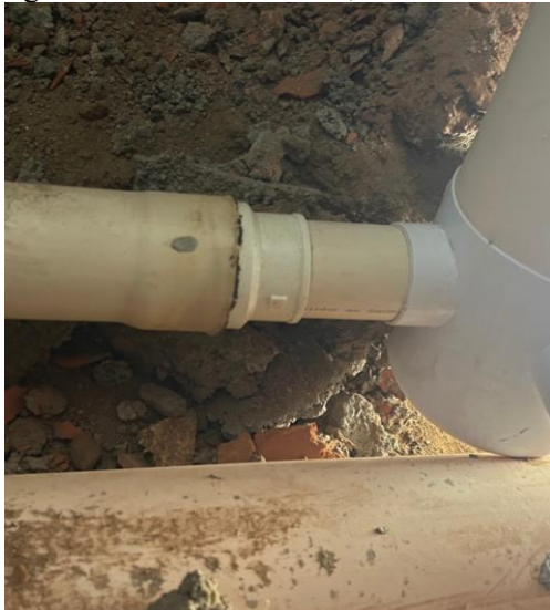
Figura 84 – Caixa sifonada, banheiro social
