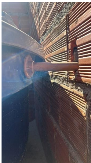
Figura 25 – Tubo extravasor (ladrão)
