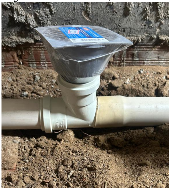
Figura 82 – Ralo fora do box, banheiro social
