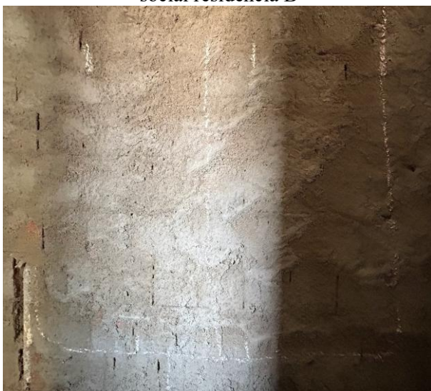
Figura 52 – Traçado sobre a parede, banheiro social residência B
