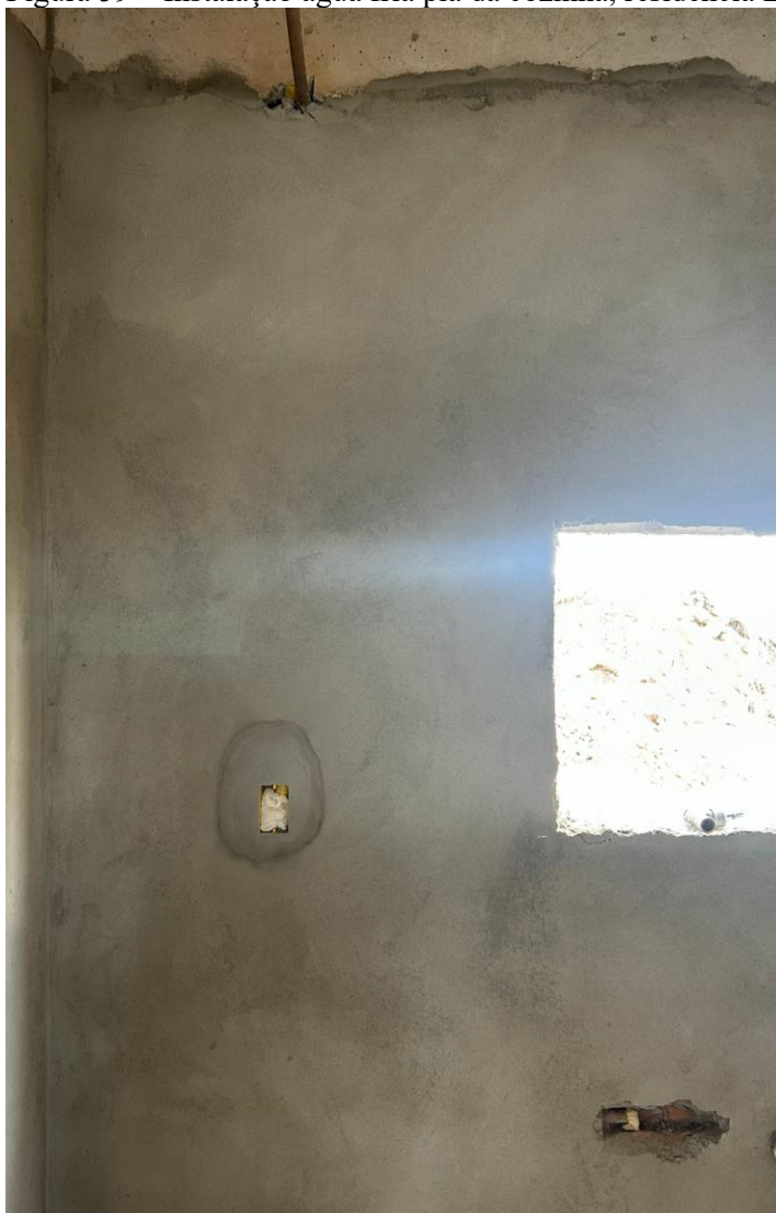
Figura 59 – Instalação água fria pia da cozinha, residência B
