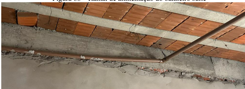
Figura 68 – Ramal de alimentação do banheiro suíte
