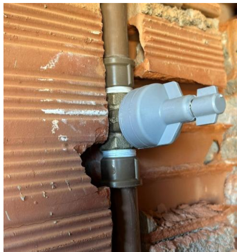
Figura 35 – Registro geral, banheiro suíte
