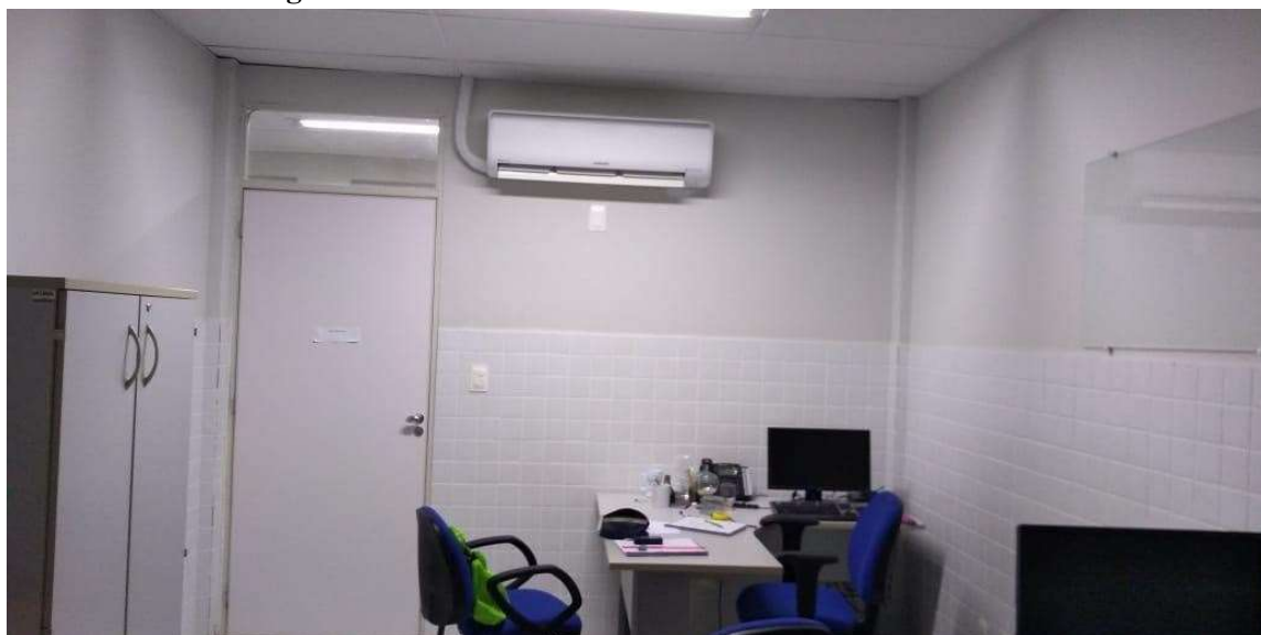
Figura 14- Vista interna Sudoeste-Nordeste da sala 16
