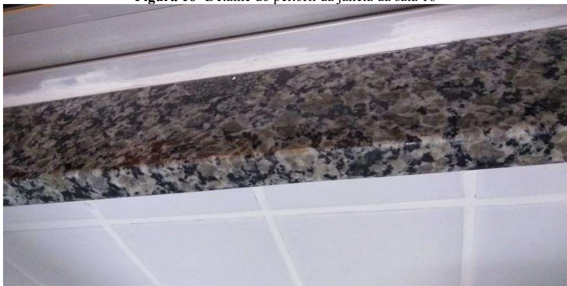
Figura 16- Detalhe do peitoril da janela da sala 16
