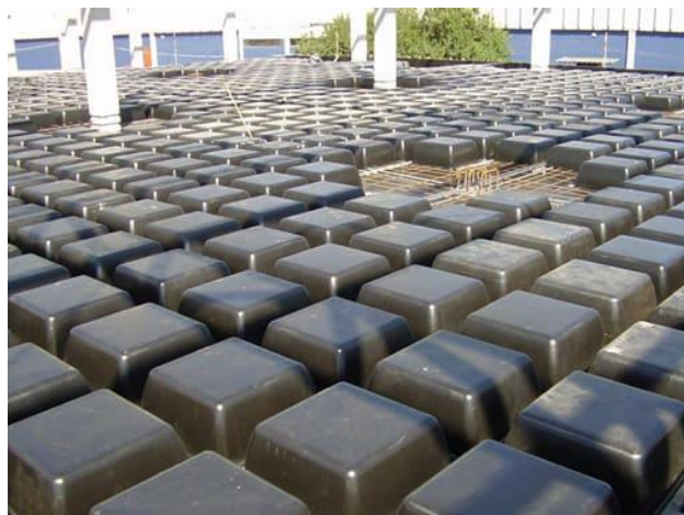
Figura 5: Disposição das cubetas em uma laje nervurada.
