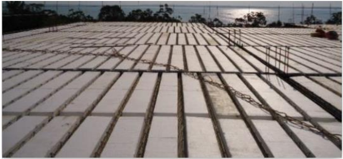
Figura 6:Laje Trelaçada com preenchimento de EPS.
