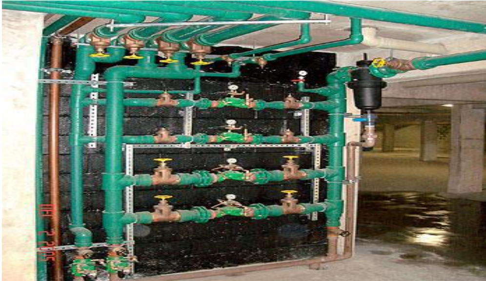
Figura 03: VPR (Válvula Redutora de Pressão)
