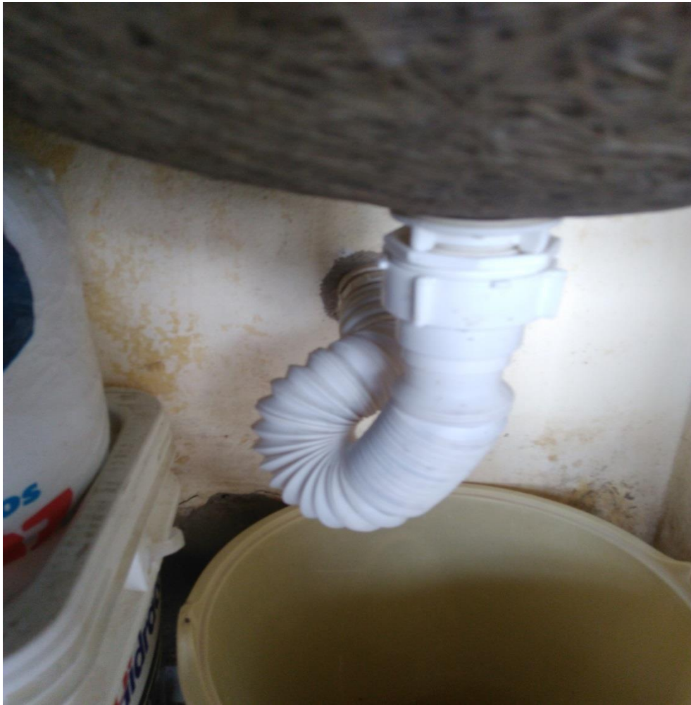
Figura 20: Sifão inadequado
