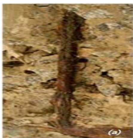
Figura 1- Aparência superficial da corrosão generalizada desencadeada pela carbonatação do concreto(a) - Corrosão puntiforme desencadeada pela ação dos íons cloreto (b)
